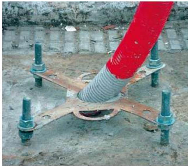
Detalle de realización de cimentación con pernos sueltos y plantilla.
