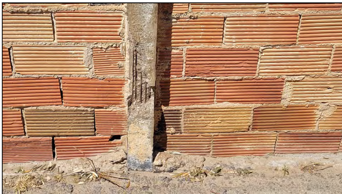
Deteriorament en les biguetes que formen les traves dels trams del mur
