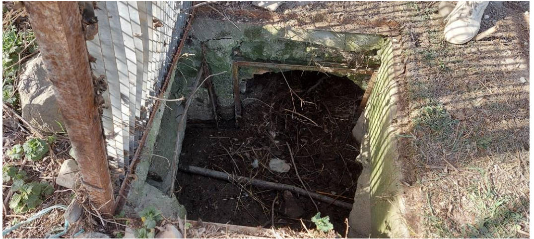
Vista de tramo de cuneta colmatado de gravas y arqueta colmatada de sedimentos (punto 3).
