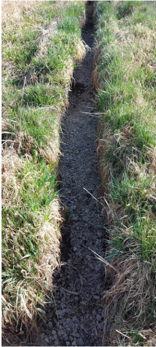
Vista de tramo de cuneta colmatado de gravas y arqueta colmatada de sedimentos (punto 3).
