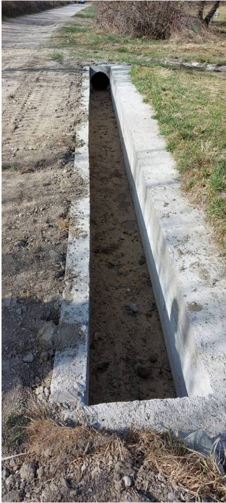
Vista de tramo de cuneta reparada con hormigón in situ encofrado y ferrallado.
