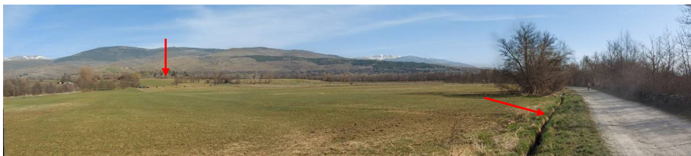
Vista de cuenca nº2 y su punto más elevado en carretera N-260 a cota 113 m. Camino real reparado observa la cuneta longitudinal de recogida del flujo difuso de la vertiente, muy dañada en un tramo aproximado de 80 m.
