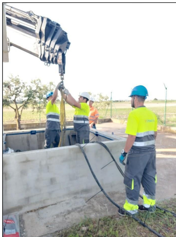
Imatge 1. Ubicació del pou, lloc de treball i treballadors implicats
