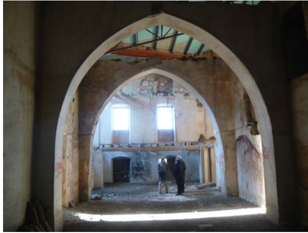
Imatge 11.- espai de la crugia interior amb els arcs diafragmàtics
