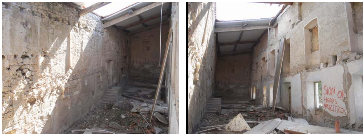
Imatges 20a i 20b .- vistes interiors de les façanes a la plaça Palau i a l'exterior sud-oest
