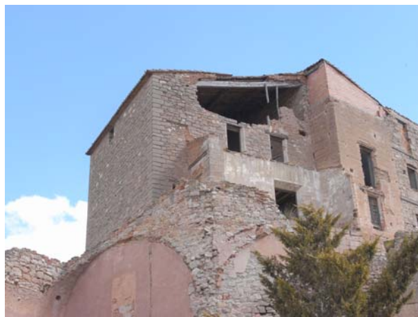
Imatge 2.- Vista del volum nord amb la façana nord oest i les restes de la porxada
