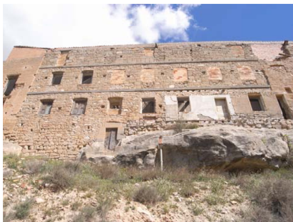
Imatge 18 .- Façana barroca sud-oest
