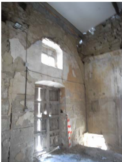
Porta accés exterior
