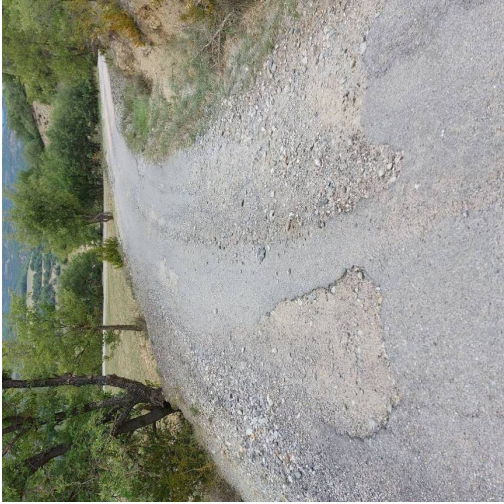
Fotografia núm. 12 : pK 2+519, estabilització núm. 8, longitud 20 m.
