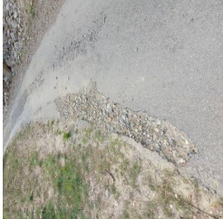
Fotografia núm. 29 : pK 3+621, reparació local de clot.
