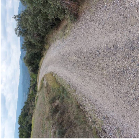
Fotografia núm. 68 : pK 0+380, longitud 60 m, només escombrat superficial.
