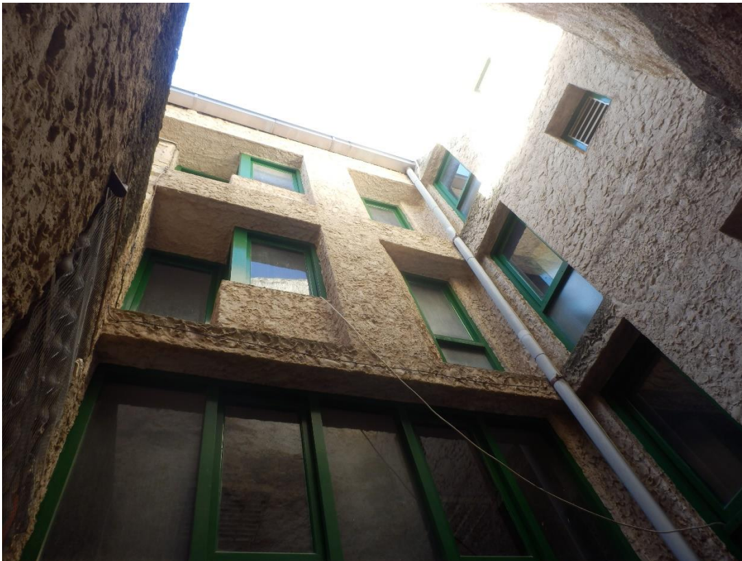
F04. Vista general de la façana posterior al pati interior.
