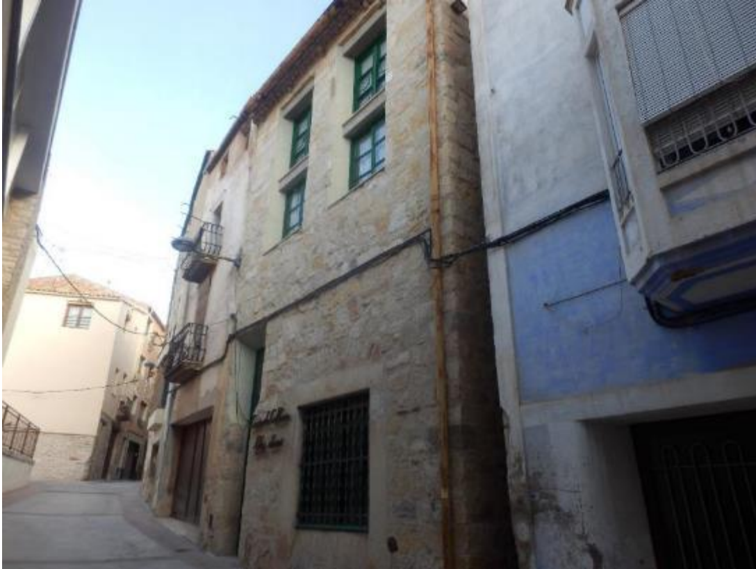
F01. Vista general de la façana amb l'accés a l'edifici.
