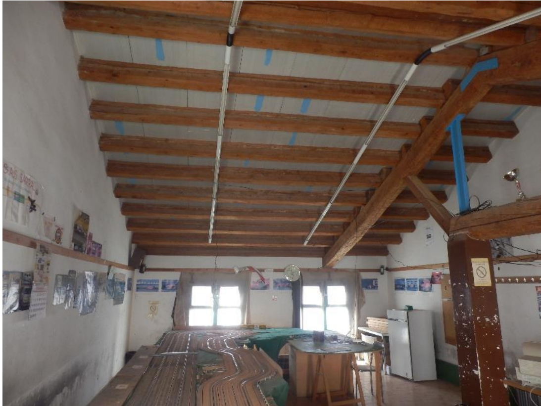
F13. Vista general de la sala a la planta tercera.
