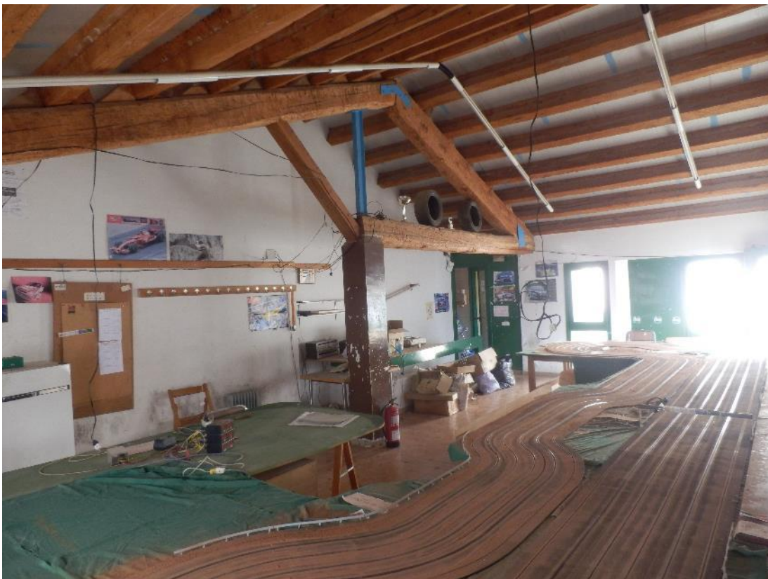
F14. Vista general de la sala a la planta tercera.
