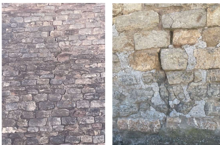
Vistes de l'esquerda en el parament exterior (façana)
