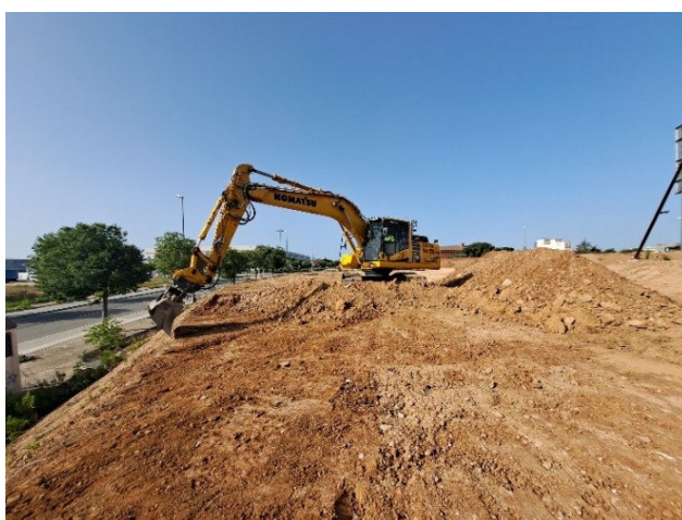
Figura 29. Vista general del procés d'excavació del solar. Orientació sud-est.
