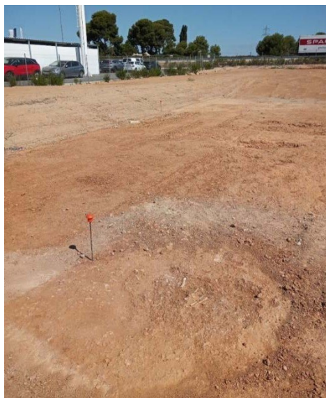
Figura 6. Vista general de la zona d'intervenció abans de l'inici de l'excavació. Orientació nord
