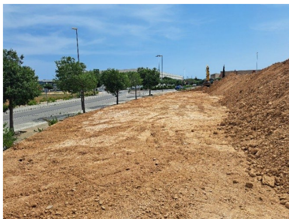
Figura 31. Vista general del solar una vegada finalitzat el rebaixdel sector est. Orientació sud.
