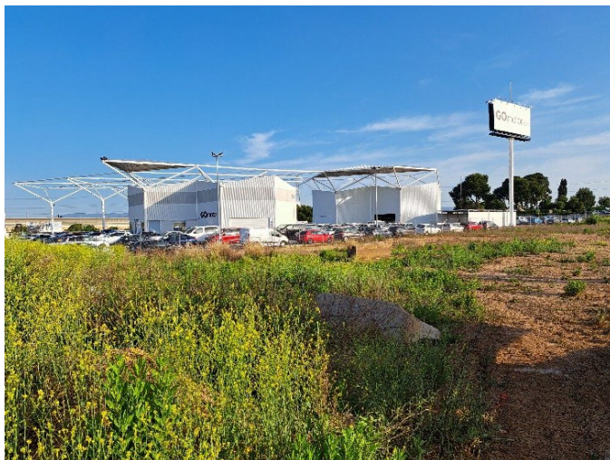
Figura 3. Vista general de la zona objecte dels treballs abans del'inici de la intervenció. Orientació oest.
