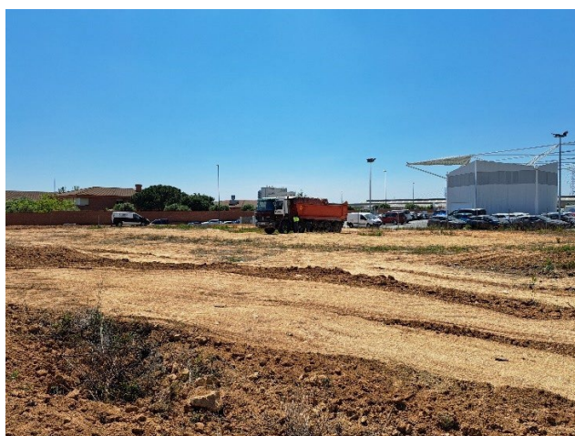
Figura 10. Vista general del procés dels treballs d'excavació del solar. Orientació oest
