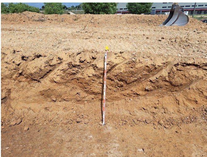
Figura 23. Vista en detall de la profunditat del rebaix assolit en una part del solar. Orientació est.
