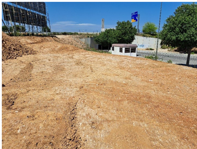
Figura 30. Vista general del solar una vegada finalitzat el rebaixdel sector est. Orientació nord.
