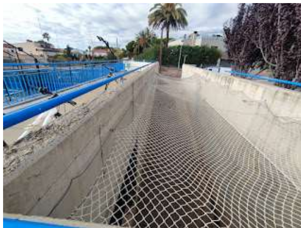
2 Rampa espai inferior zona d'accés
