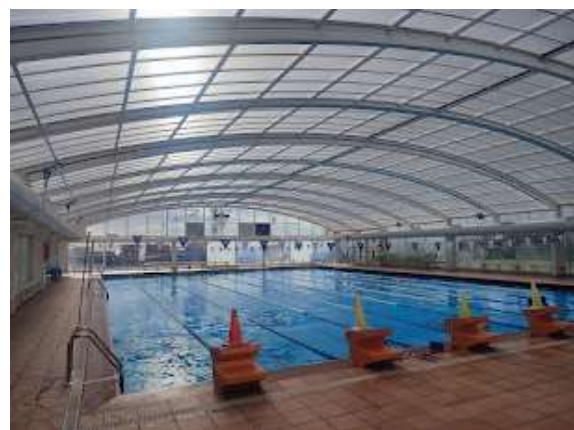
11 Piscina de 25x16,60 m i 1,90 a 2 m de fons
