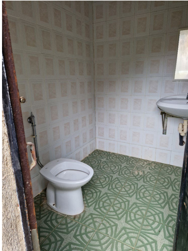
Fotografies Estat Actual Lavabo 1
