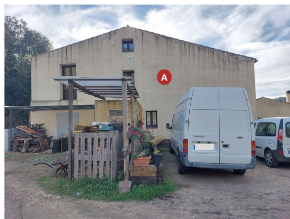
Façana nord-oest edificis A
