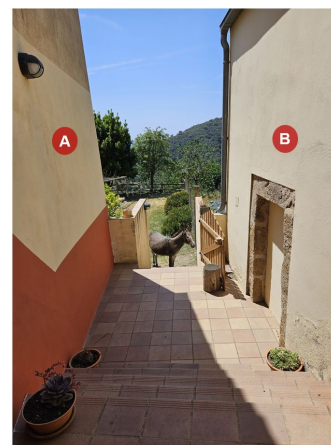
Façana sud-oest edificis A i nord-est edifici B
