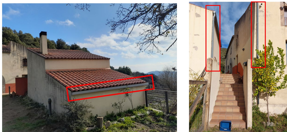
Canals i baixants de l'edifici A i B
