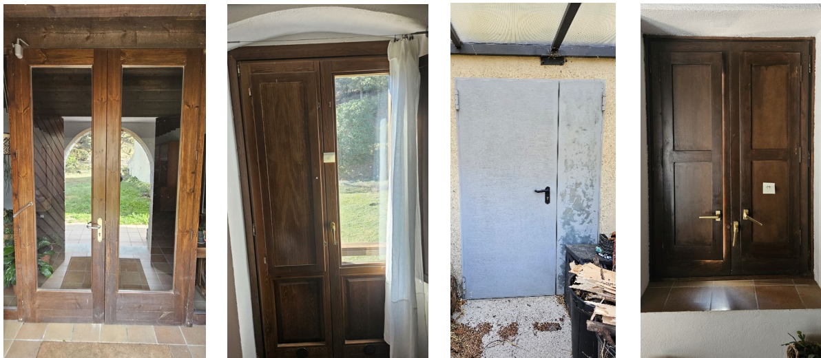
Figura 22: Fotografies de fusteries i accessos de planta baixa Font: Pròpia
