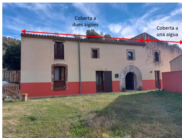
Figura 27: Fotografies indicant la tipologia de les cobertes inclinades en l'edifici A Font: Pròpia
