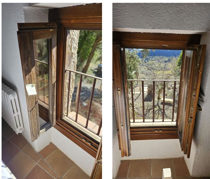
Figura 26: Fotografies de finestres amb baranes de seguretat existents en l'edifici A Font: Pròpia
