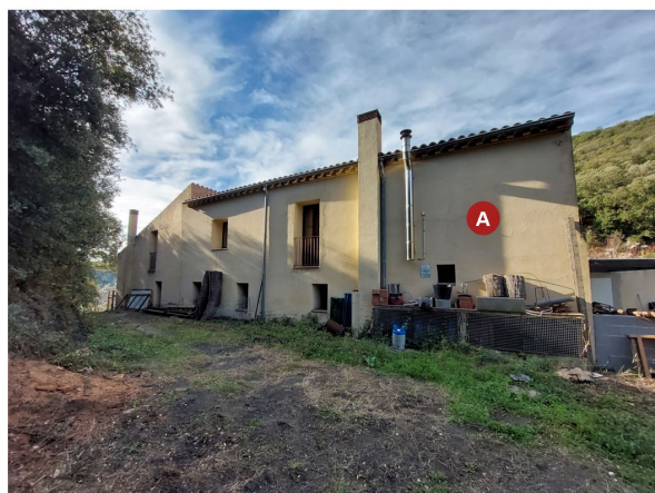
Façana nord-est edifici A
