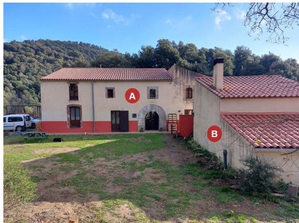
Façana sud-oest edificis A i nord-oest edifici B
