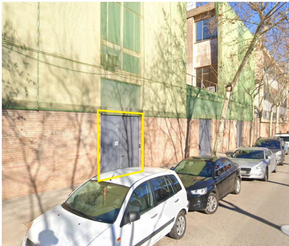
Fig. 1414 - Accés a carrer de les noves instal·lacions
