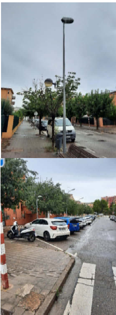
Figura 3 – Estat actual enllumenat públic carrer Ter
