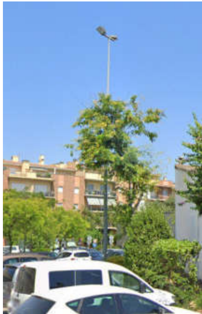
Figura 6 – Estat actual – projectors halògens aparcaments darrera jutjats
