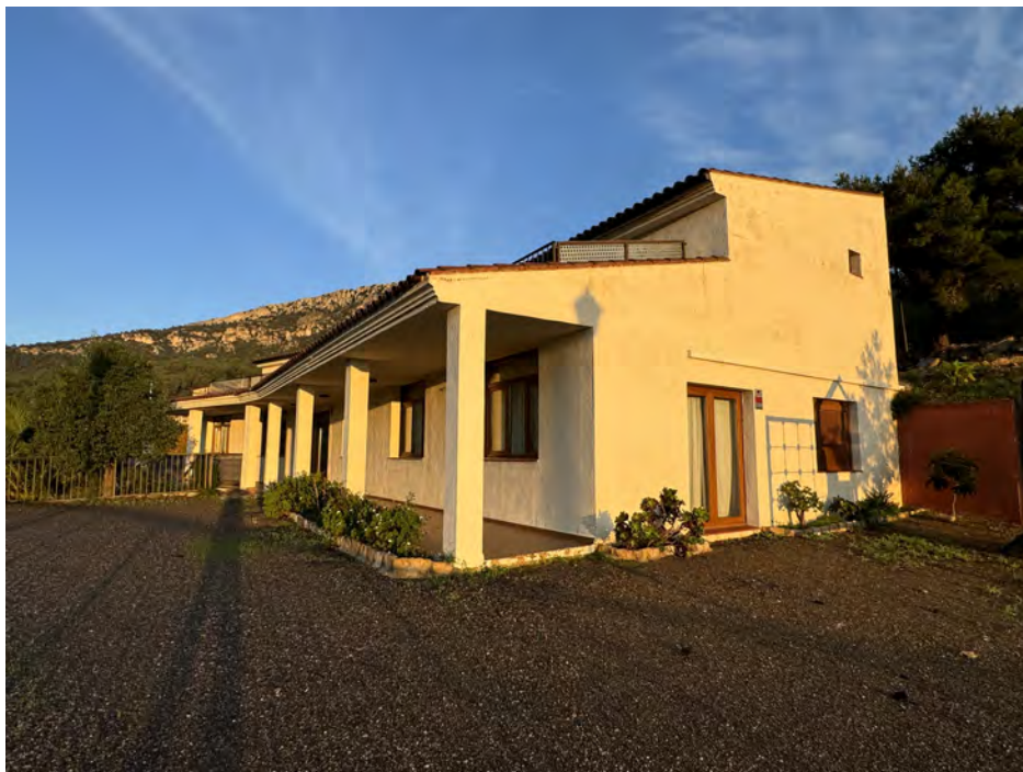
D.F.5 Cantonada a sud-est amb accés a planta baixa.
