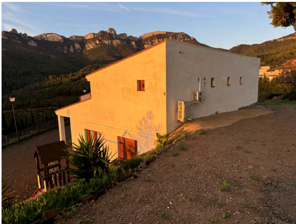
D.F.1 Cantonada a nord-est amb els dos accessos.
