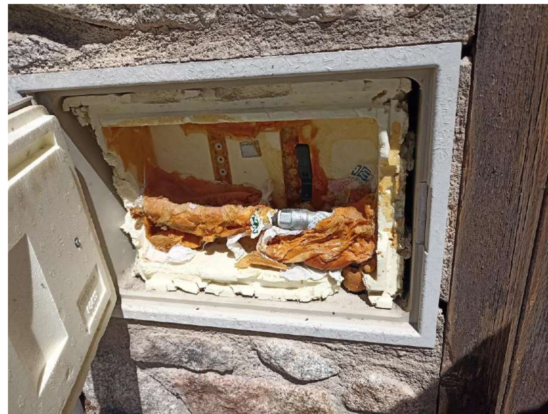
Figura 8. Arqueta de paret, en estat correcte.
