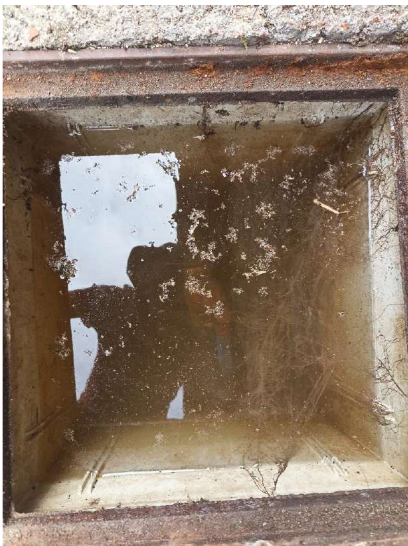
Figura 5. Arqueta quadrada embussada.
