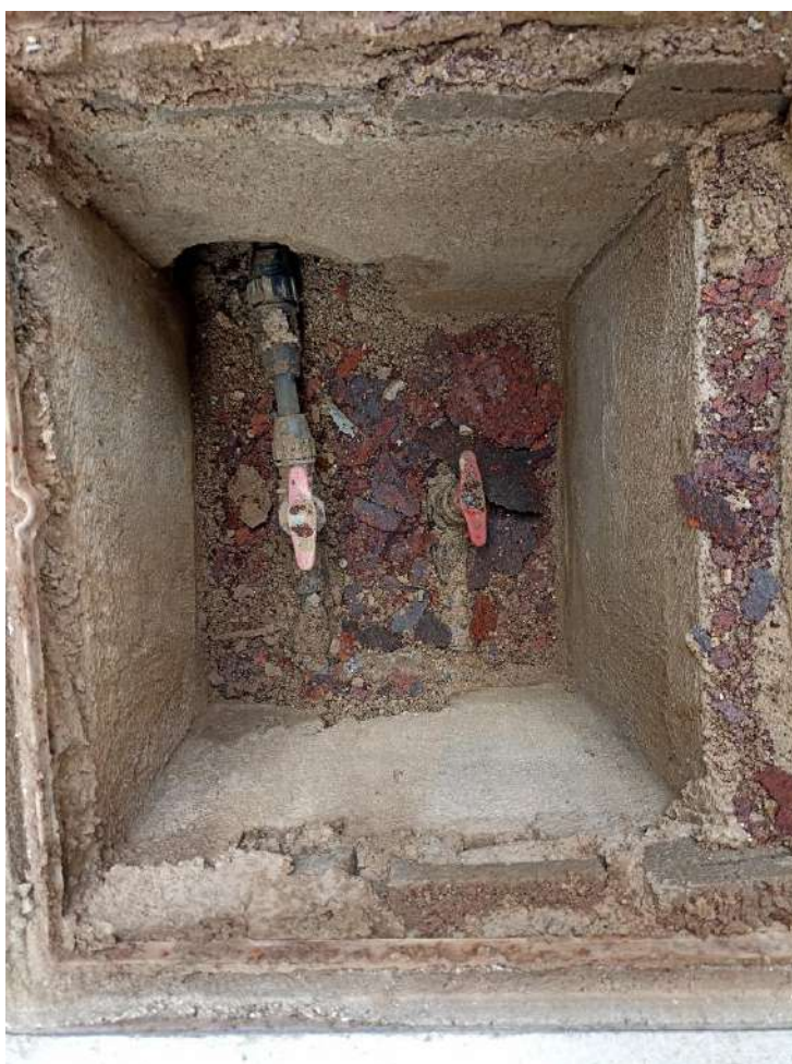
Figura 3. Arqueta tipus quadrada amb dues canonades.
