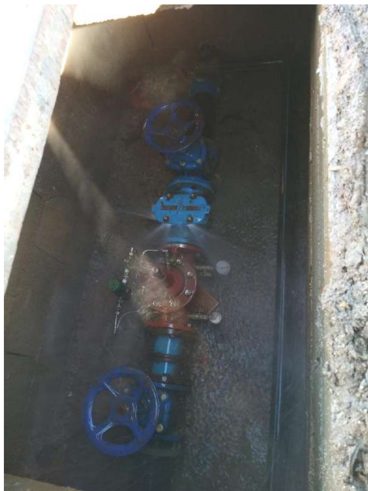
Figura 1. Tipus de reguladora de pressió del nucli
