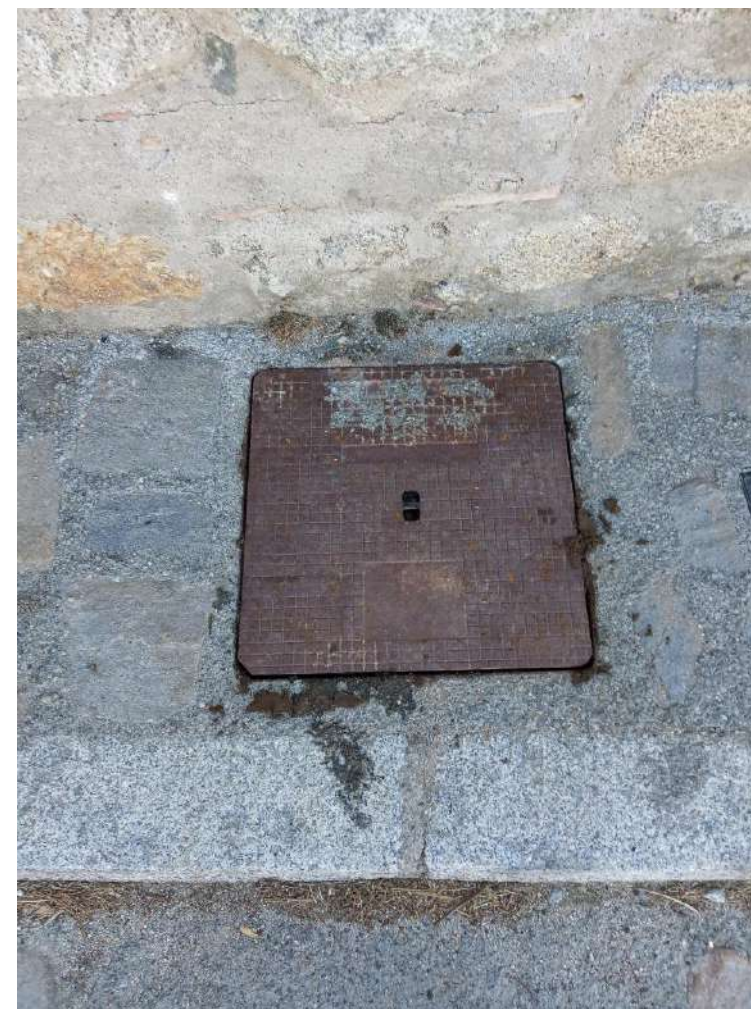
Figura 2. Arqueta tipus exterior, sobre paviment.
