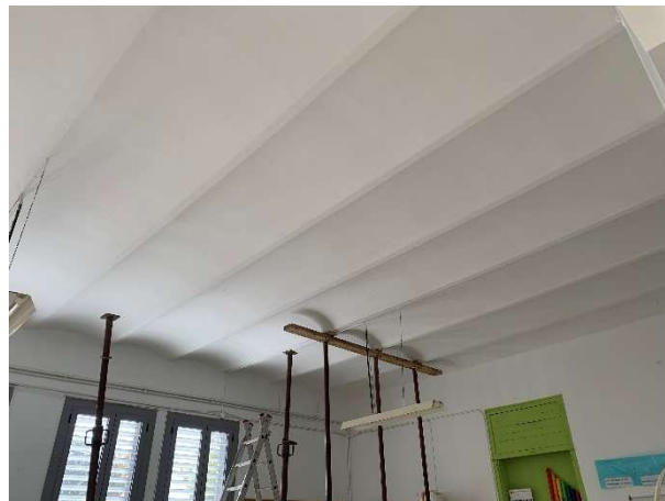
Vista del forjat a reforçar durant la col·locació de l'apuntament (novembre de 2023)
