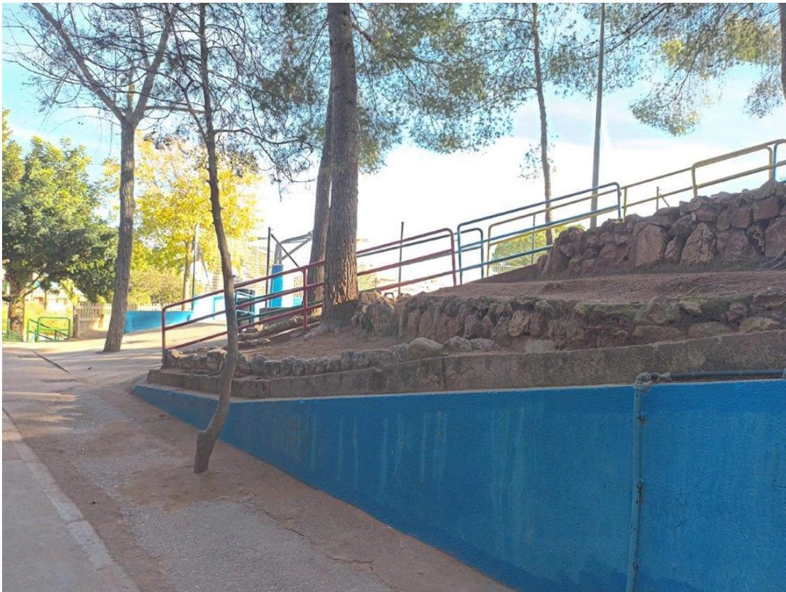
10 Escales d'accés Zona B
