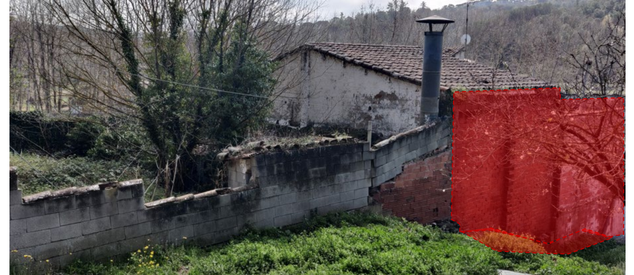
Zona del pati de la finca 3 afectat per l'ocupació temporal, amb una superfície de 16,56m 2 en planta. Font: pròpia.
