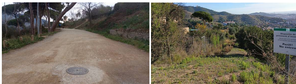
Imatge 12: Estat actual de l'accés per la Carretera de les Aigües i l'antic punt d'aigua.
