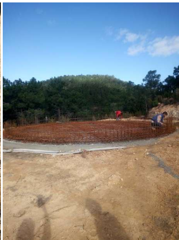
Exemple de la construcció de l'armadura per la sabata.
