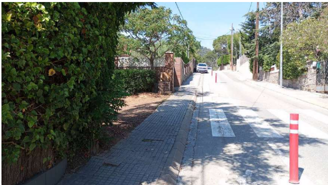
Punt de captació d'aigua al Passeig de la Guineu.
