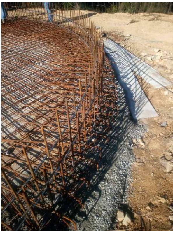
Exemple de la construcció de l'armadura per la sabata.
