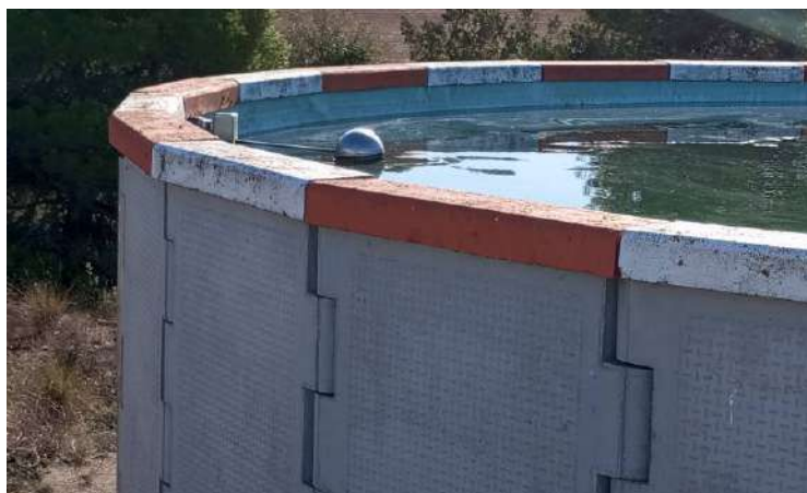
Exemple del sistema d'abastiment automàtic amb boia i la instal·lació del tub d'abastiment.
