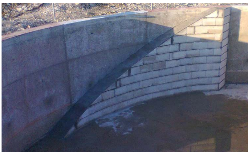
Imatge 36: Imatge de rampa de fauna d'obra per punts d'aigua.
