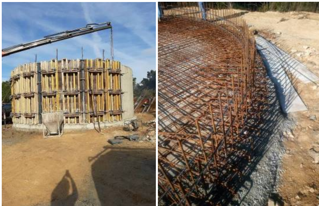
Imatge 34: Exemple d'encofrat tipus circular i armat de la sabata del punt d'aigua.
