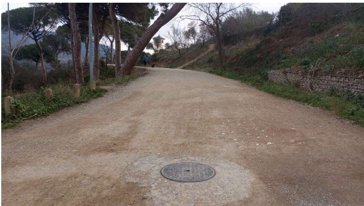
Camí per la realització de la canalització d'aigua al lateral de la Carretera de les Aigües.
