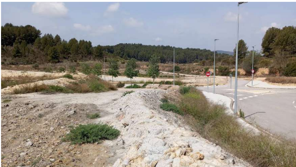
Camí d'accés existent a la ubicació del nou punt d'aigua.
