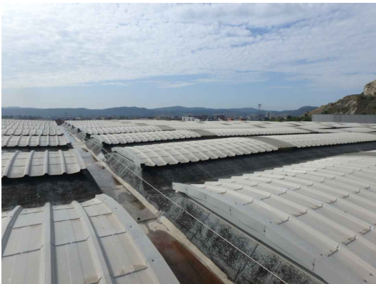
FOTOGRAFIES ESTAT ACTUAL : TELA ASFÀLTICA, PLANXA GRECADA I CLARABOIA
