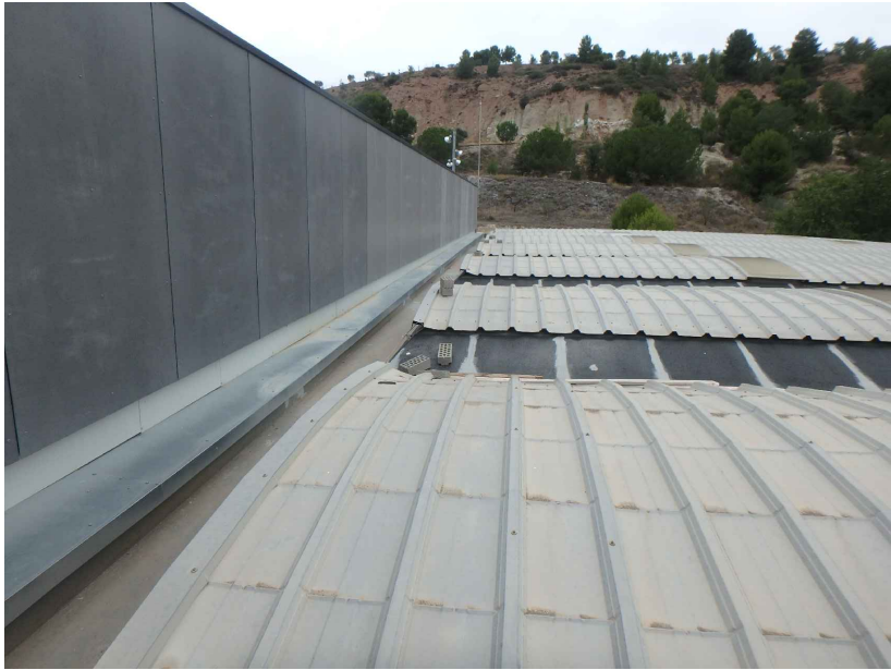
FOTOGRAFIA ESTAT ACTUAL
