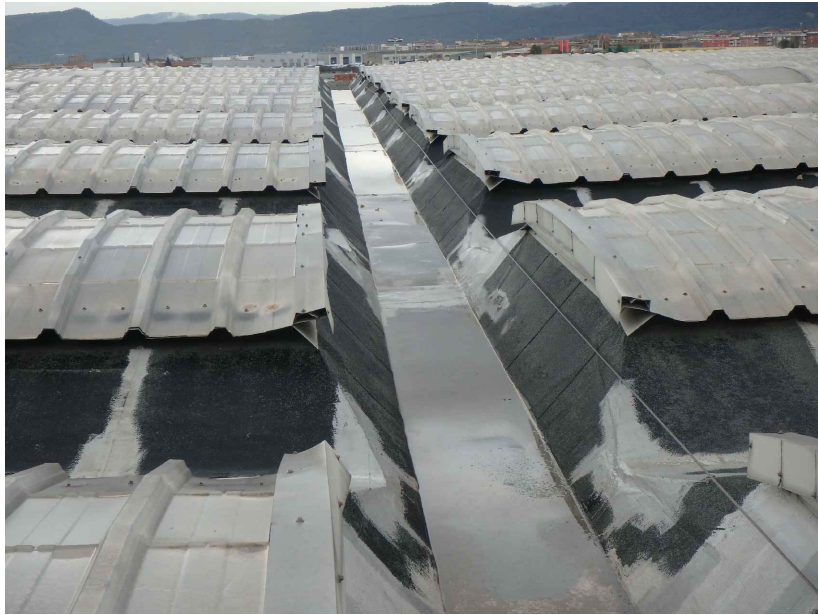
FOTOGRAFIA ESTAT ACTUAL
