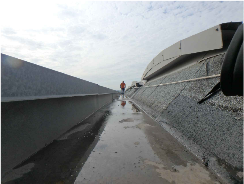
FOTOGRAFIA ESTAT ACTUAL
