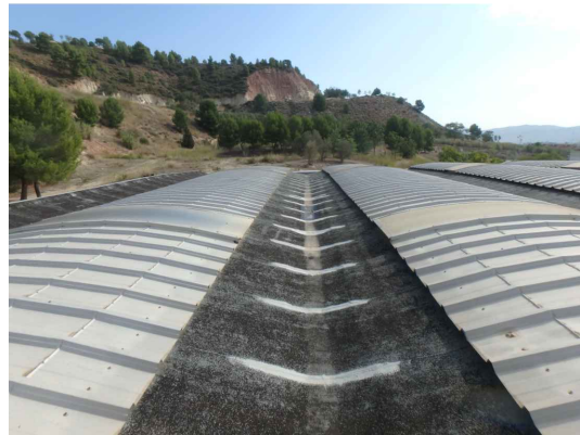
FOTOGRAFIES ESTAT ACTUAL : TELA ASFÀLTICA, PLANXA GRECADA I CLARABOIA
