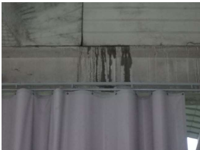
FOTOGRAFIES ON ES MOSTREN DIFERENTS PUNTS DE FILTRACIÓ
