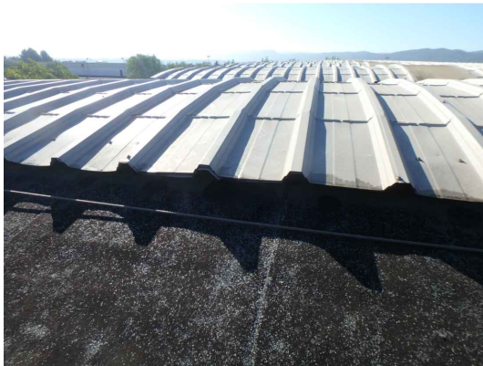
FOTOGRAFIES ESTAT ACTUAL : TELA ASFÀLTICA, PLANXA GRECADA I CLARABOIA
