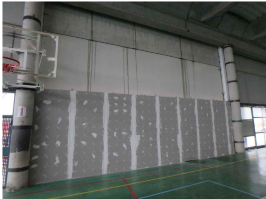
FOTOGRAFIES ESTAT ACTUAL : INTERIOR
