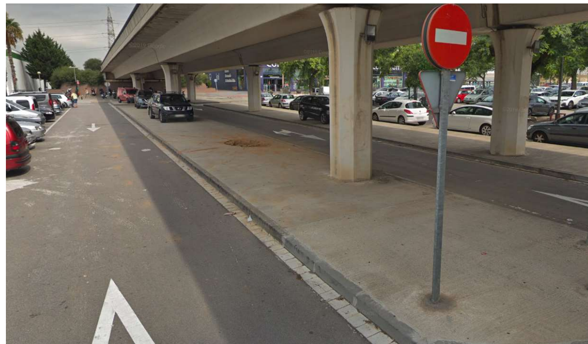
Figura 6. Espai on es construirà el centre de transformació dels subcamps C i D
