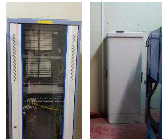
Armaris de connexió de fibra òptica i de comunicacions de l'IMI
