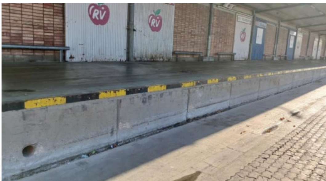
Vista de la franja de paviment de formigó i la canal prefabricada
