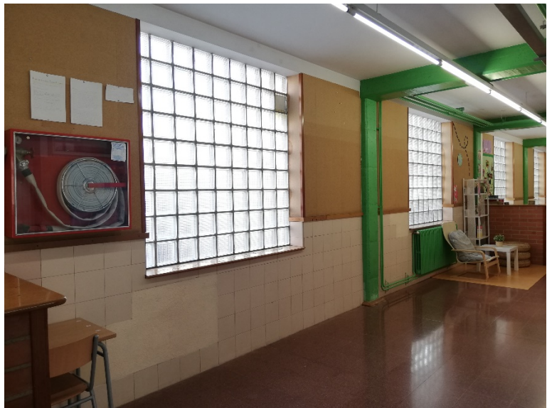
Imatge de zones reparades dels revestiments ceràmics dels arrambadors interiors
