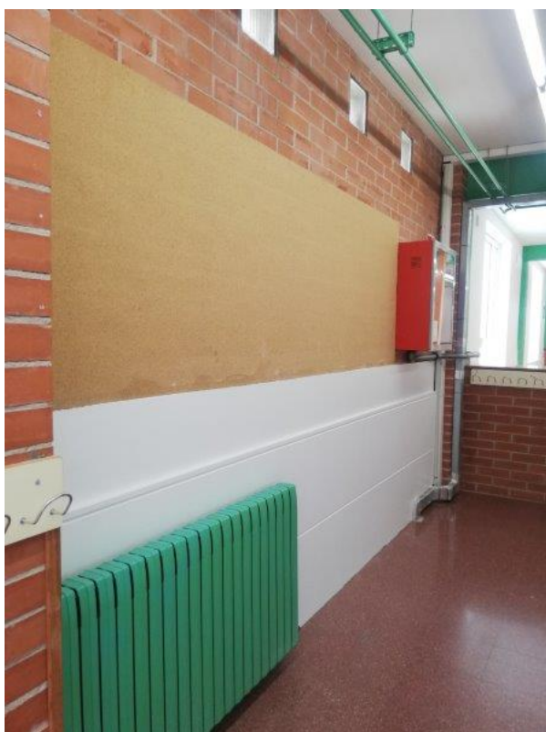
Detall dels arrambadors interiors de fusta en zona amb instal·lacions contra incendis i radiadors
