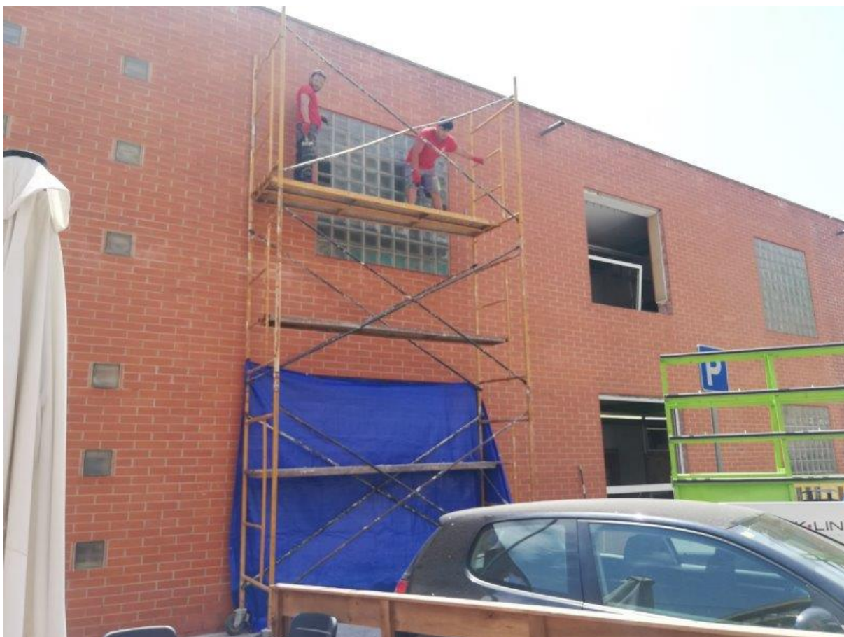
Enderroc dels tancaments de pavès de vidre de les 4 obertures
