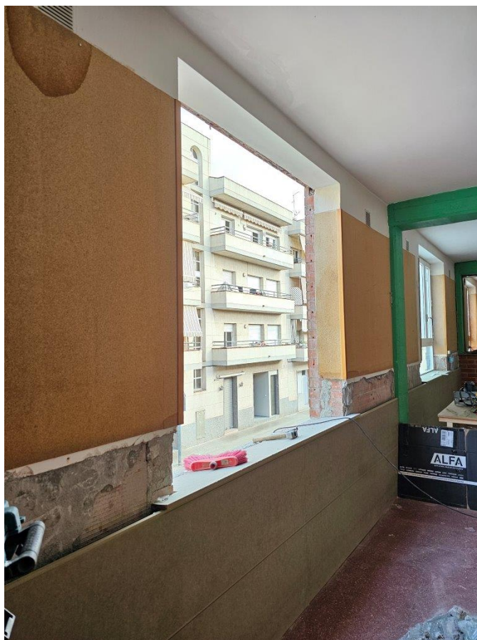
Forat net preparat per a rebre la nova fusteria, vista interior
