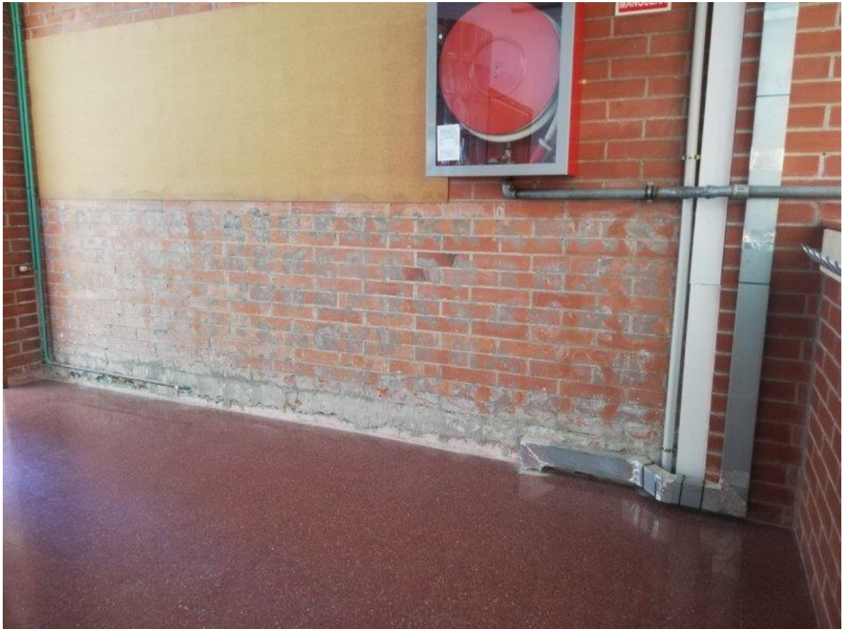
Enderroc d'arrambadors interiors en zona amb pas d'instal·lacions contra incendis i també radiadors.
