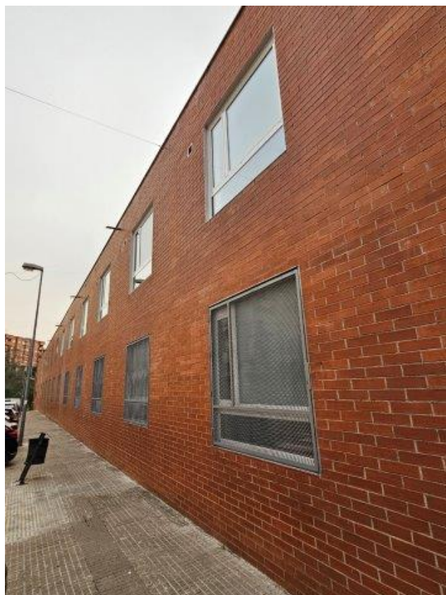
Façana amb noves fusteries i reixes col·locades
