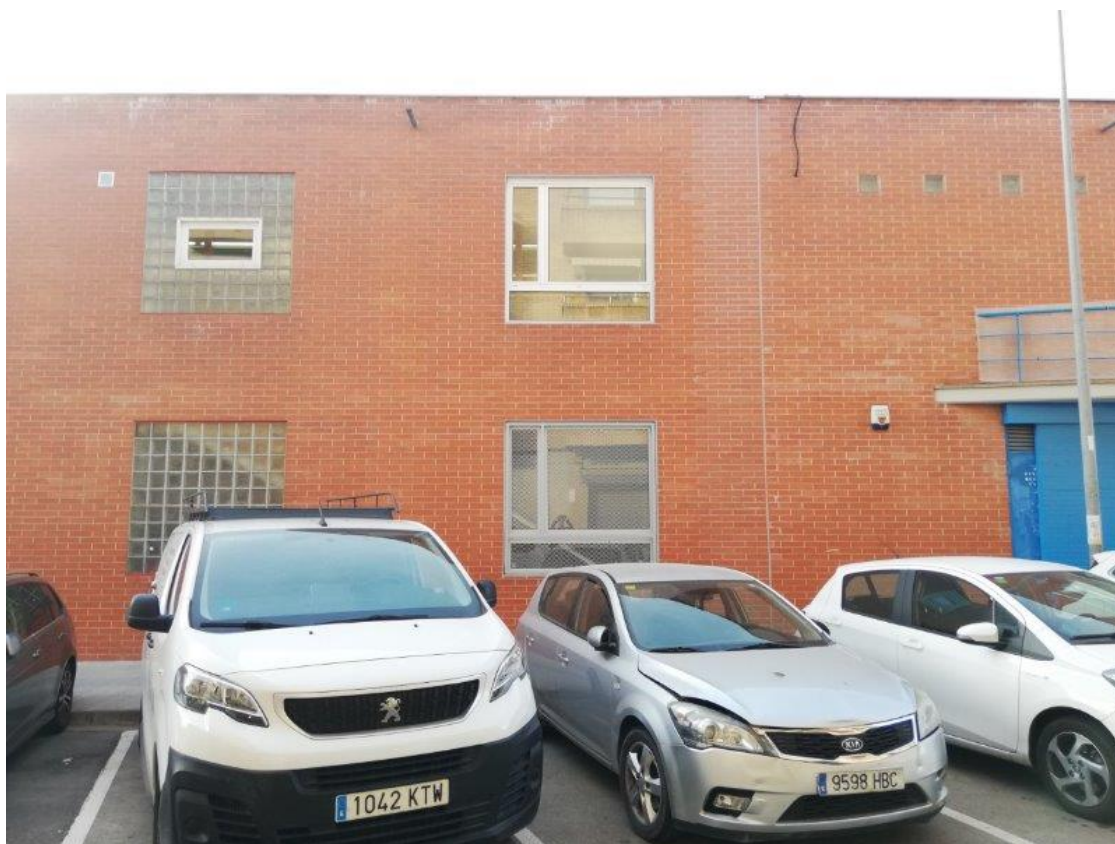
Imatge col·locació de noves fusteries practicables d'alumini en planta baixa i primera. Any 2021
