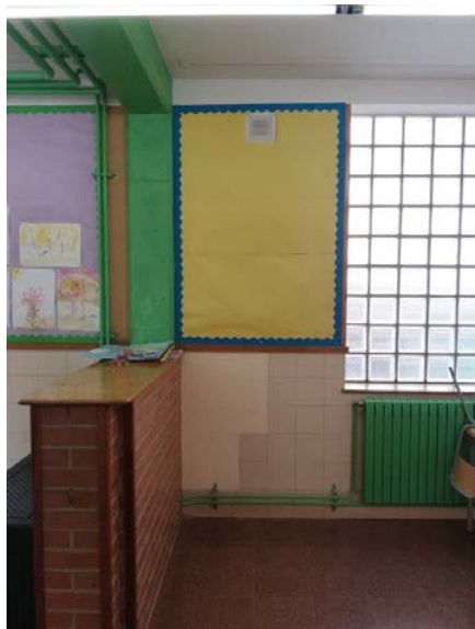
Imatge de zones reparades dels revestiments ceràmics dels arrambadors interiors
