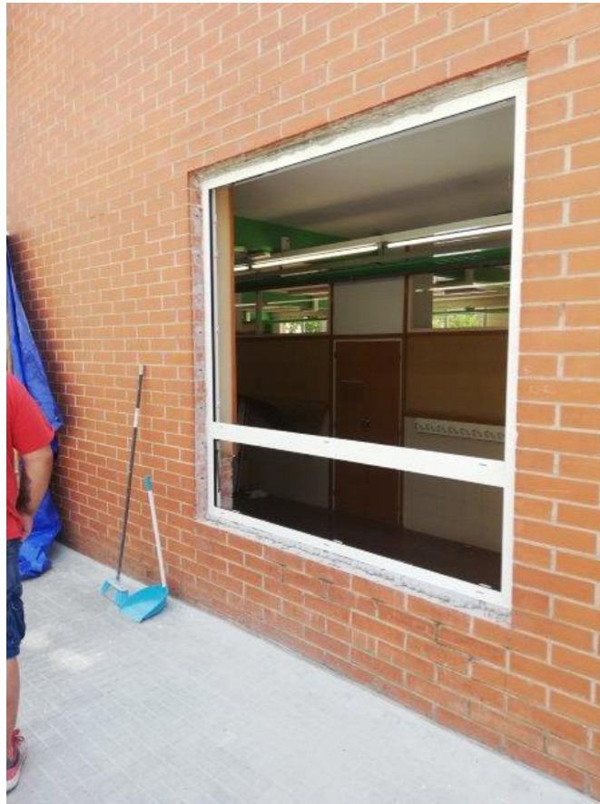
Col·locació de nova fusteria deixant espai per l'emmarcat de passamans d'acer i reixes de planta baixa
