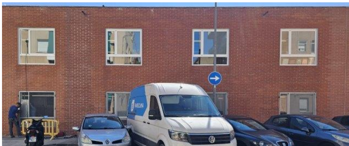
Col·locació de reixes a la resta de noves fusteries de la planta baixa
