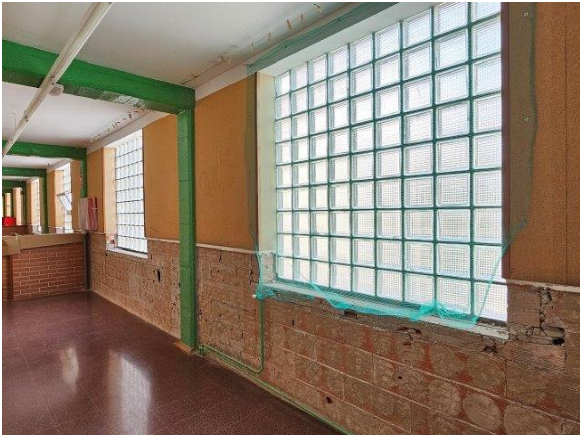
Enderroc dels arrambadors ceràmics interiors i desmuntatge de radiadors Es manté el revestiment de suro superior
