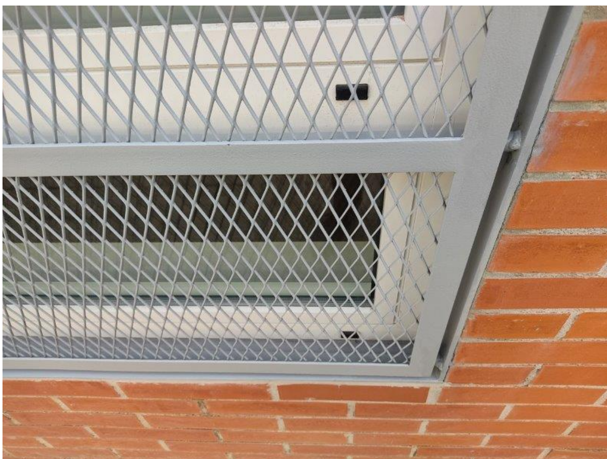
Vista de finestra inferior amb reixa i detall d'emmarcat de l'obertura i col·locació de reixa
