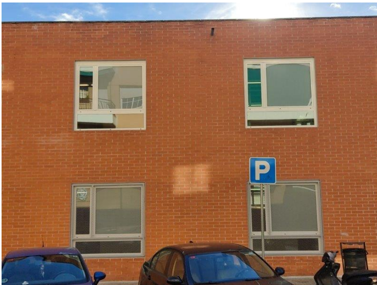
Vista de conjunt de les 4 obertures renovades. Les 2 inferiors amb reixa de protecció
