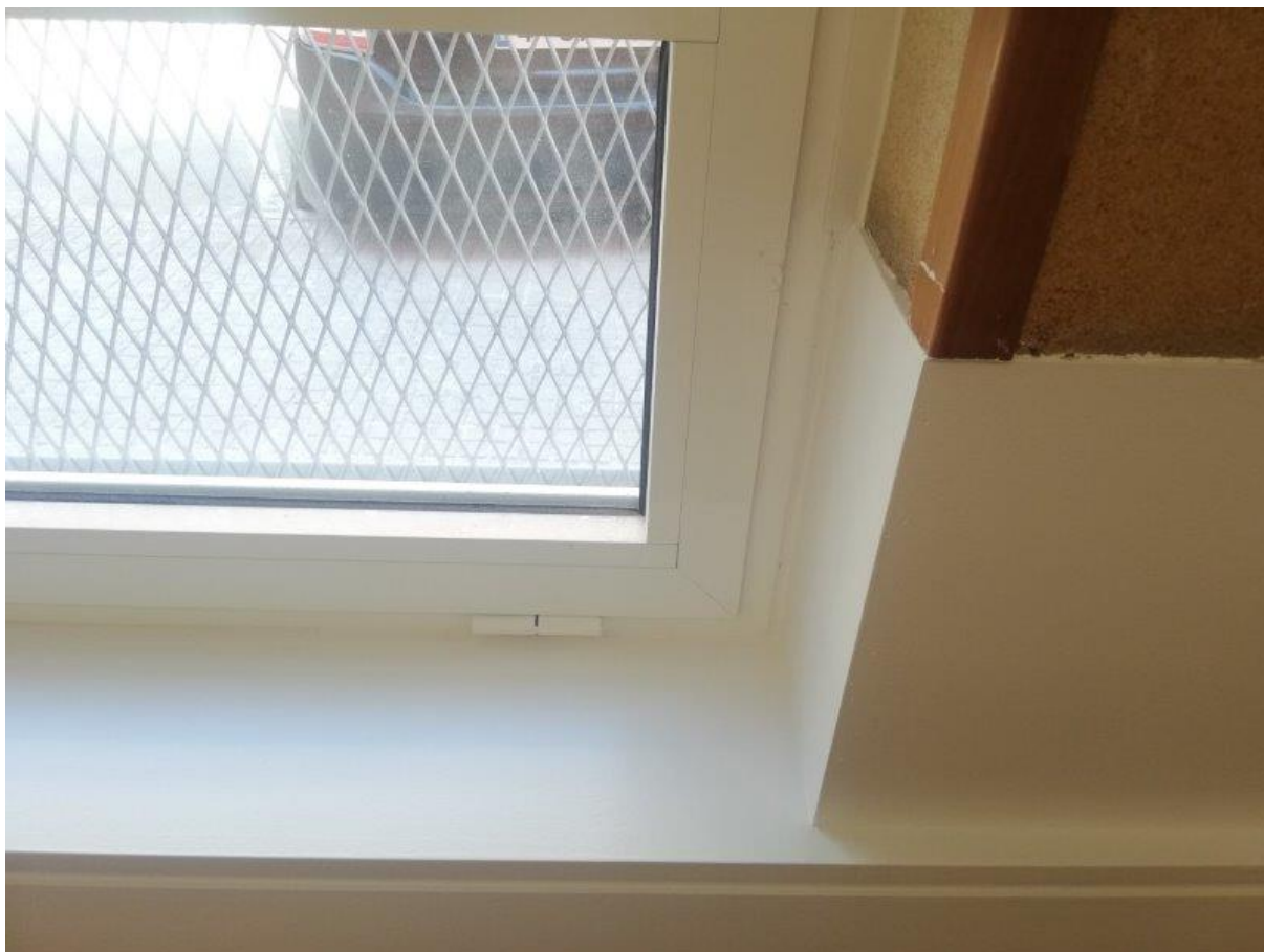
Detall dels arrambadors interiors de fusta. Part inferior amb llistons, superior cargolada i encolada.
