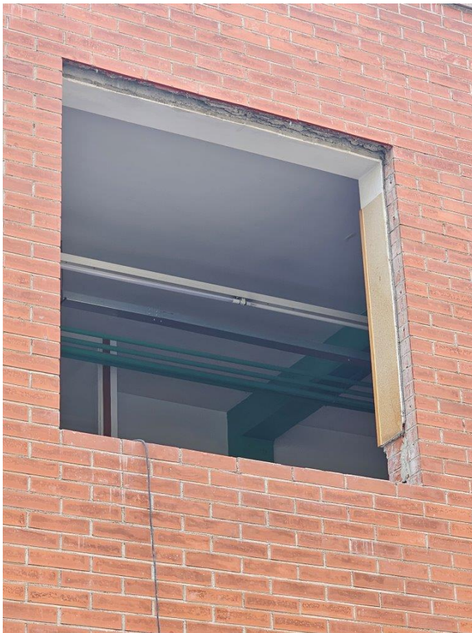
Forat net preparat per a rebre la nova fusteria, vista exterior
