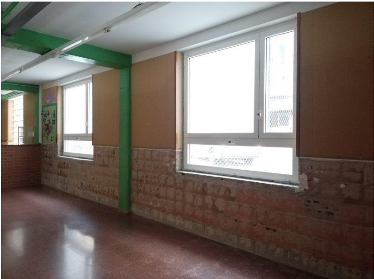
Vista interior de la col·locació de noves fusteries
