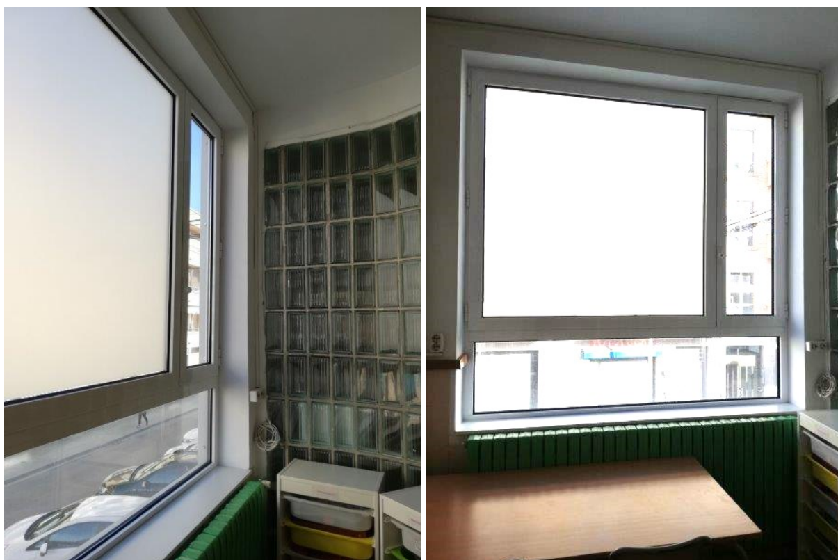
Nova finestra planta primera costat dret façana
