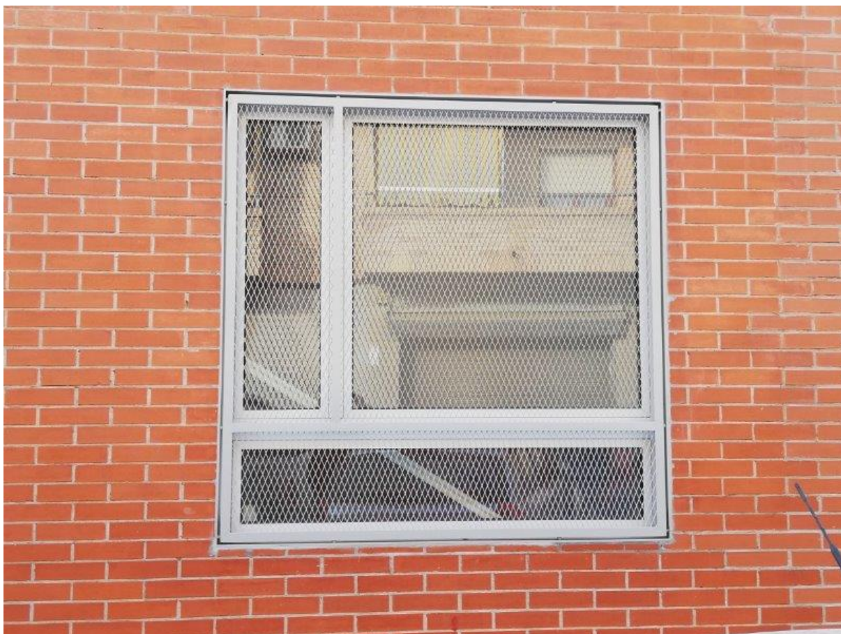
Finestra de planta baixa amb reixa de protecció de “metal deployé romboidal”
