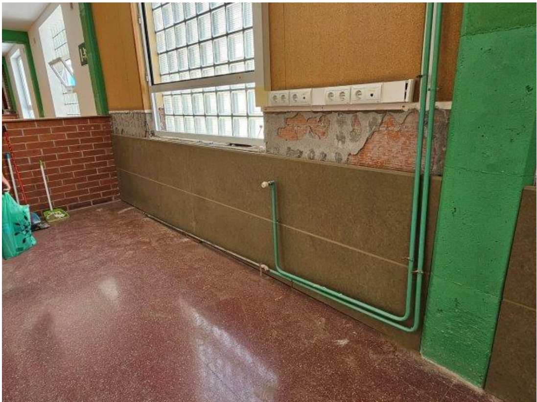
Col·locació de llistons per a rebre nou arrambador de fusta
