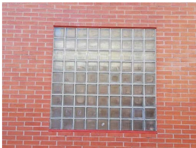
Imatge detall obertura tipus façana principal
