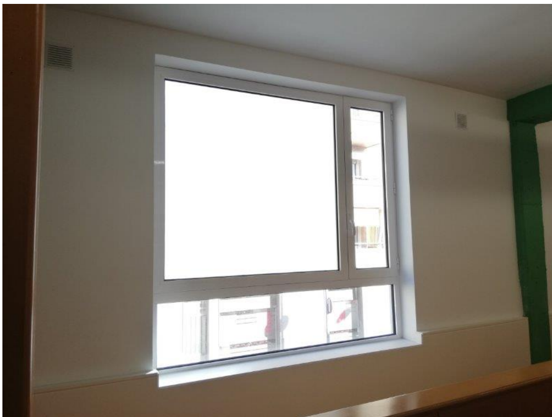
Imatge interior nova fusteria practicable d'alumini en planta primera. 2021
