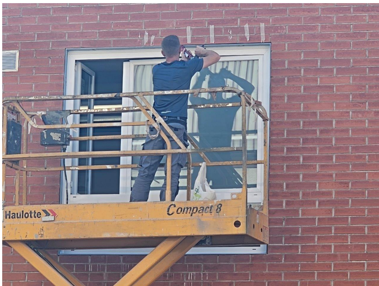
Acabat muntatge de fusteries noves en planta primera amb elevador
