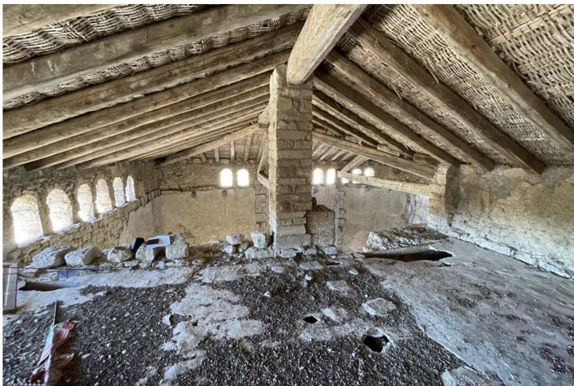
Fot 5: Fotografia actual de l'estat del forjat sotacoberta a reforçar
