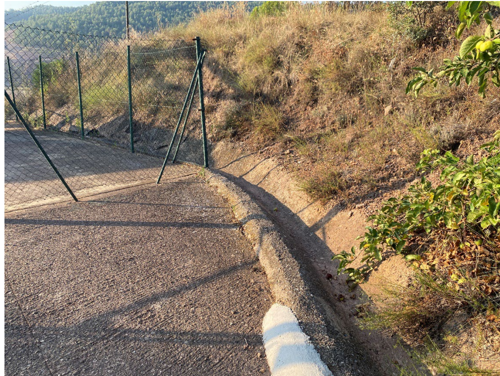
Fotografia núm. 13. Detall inici cuneta exterior recinte EBAR
