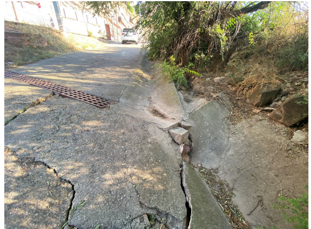
Fotografia núm. 3. Detall de l'estat de la cuneta al camí d'accés a l'EBAR
