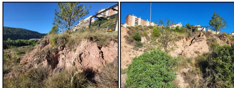
Fotografia 3 i 4. Vista de diferents xaragalls existents al talús.
