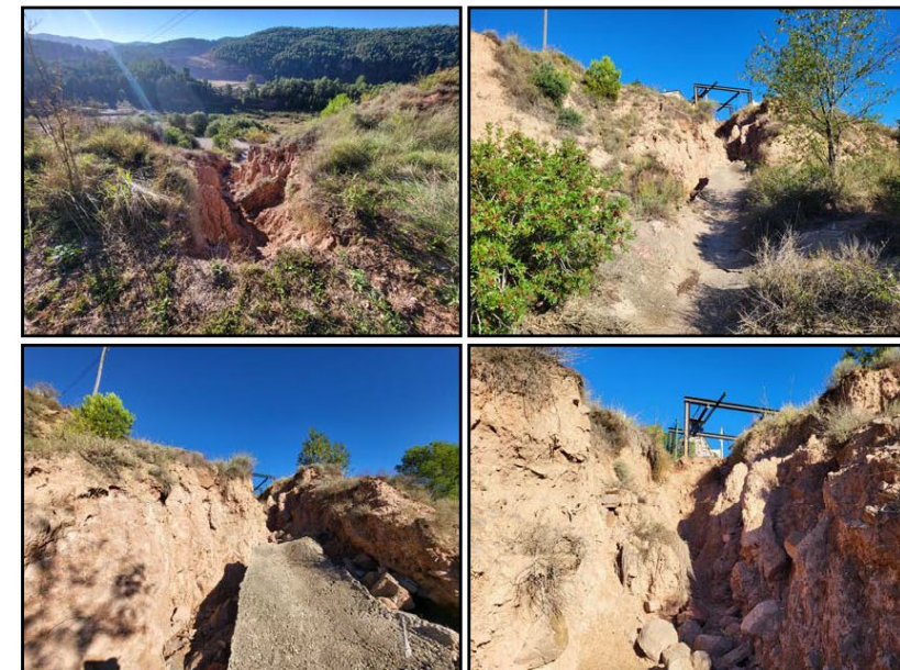
Fotografia 5, 6, 7 i 8. Vists generals i de detall del xaragall més important existent al talús.
