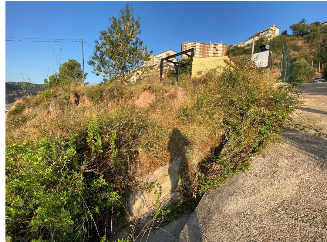
Fotografia núm. 11. Vista EBAR des del camí d'accés
