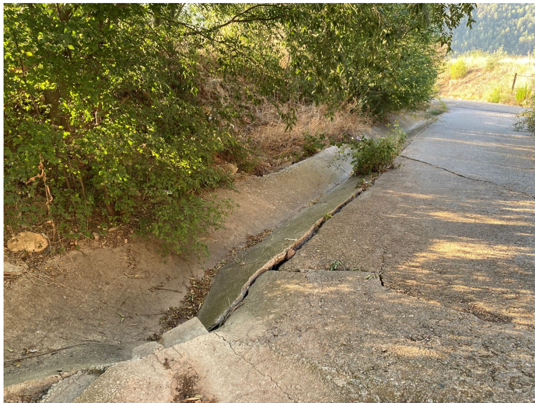
Fotografia núm. 2. Detall de l'estat de la cuneta al camí d'accés a l'EBAR
