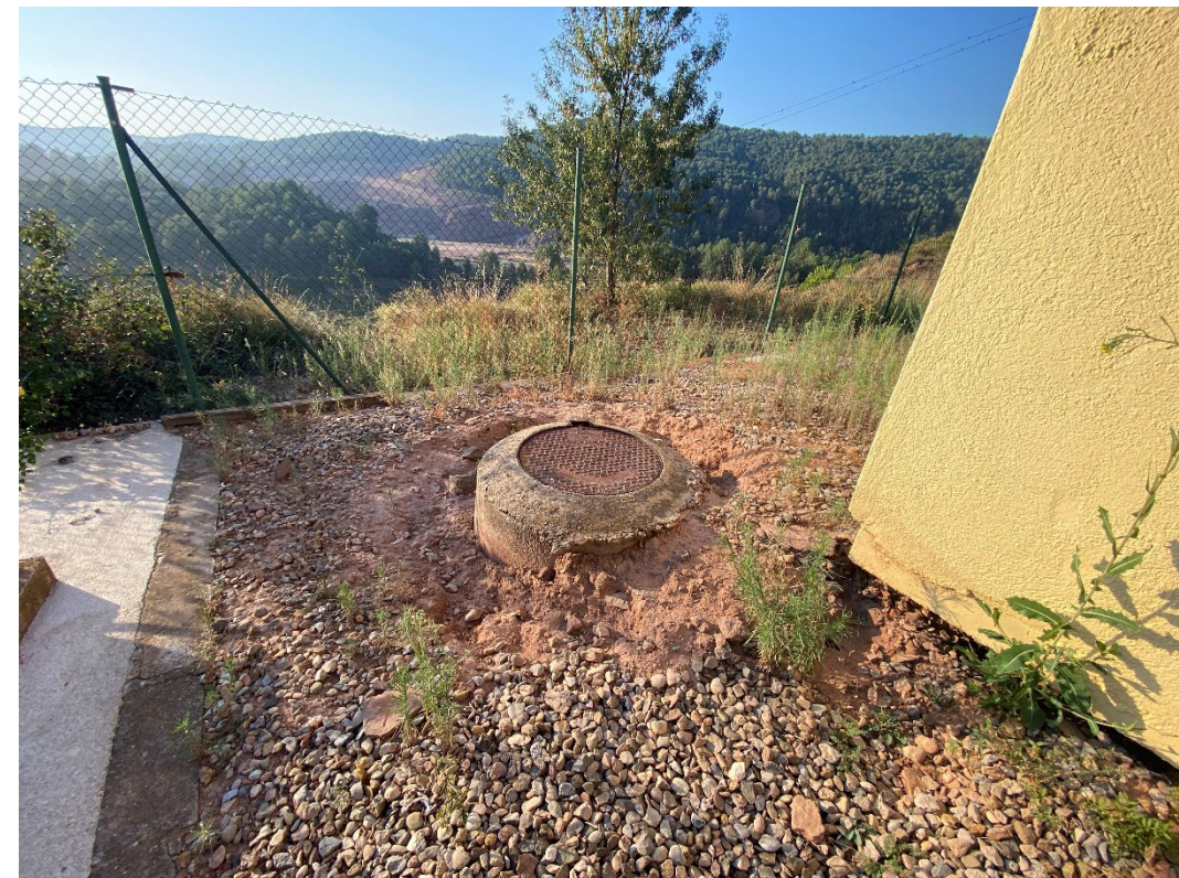
Fotografia núm. 16. Vista interior recinte EBAR
