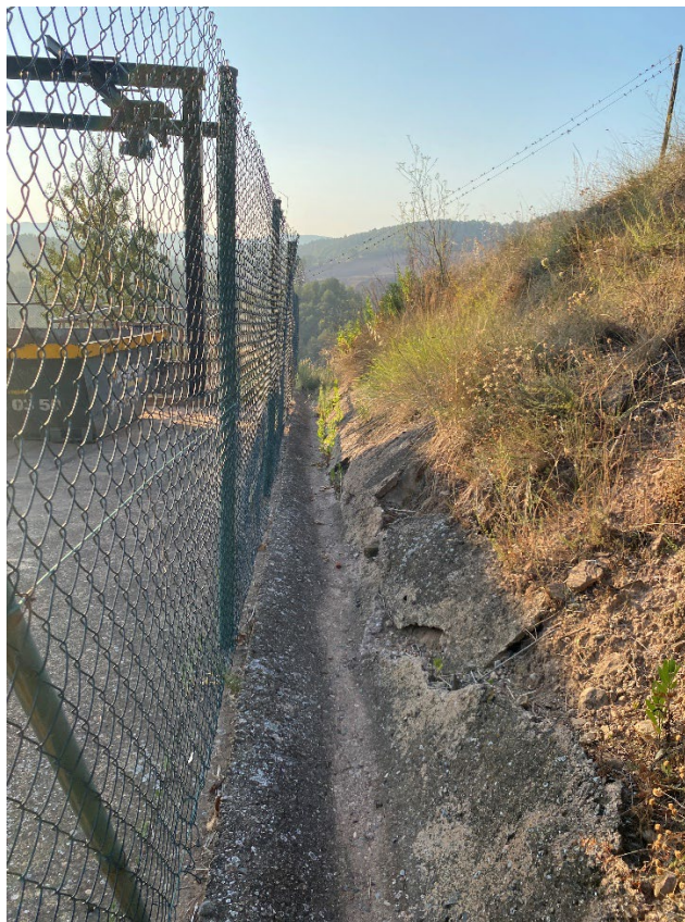
Fotografia núm. 14. Detall cuneta drenatge exterior recinte EBAR
