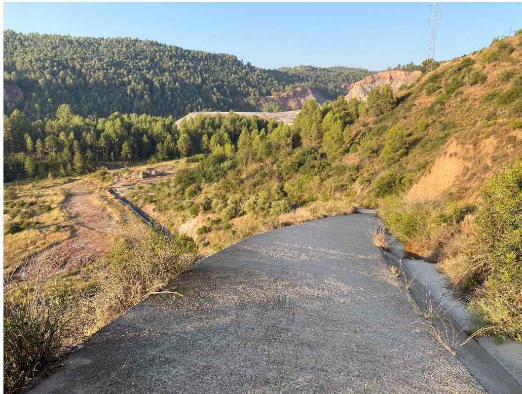
Fotografia núm. 9. Camí accés a l'EBAR
