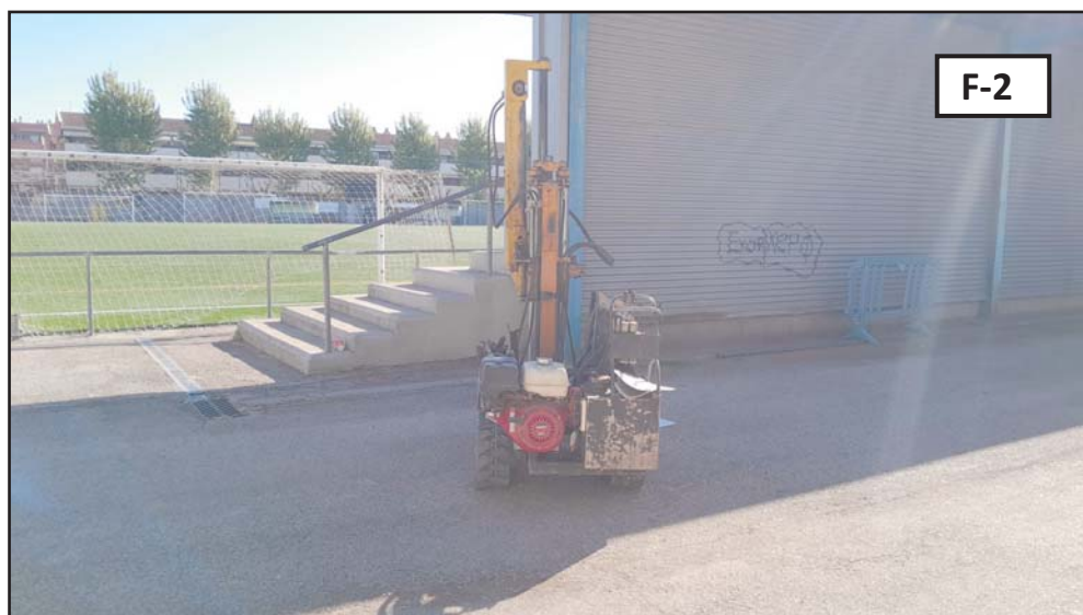
Fotografies 1 i 2: Vista general de la zona d'estudi i vista de l'emplaçament de la màquina per a la realització de l'assaig de penetració dinàmica DPSH P-1.
