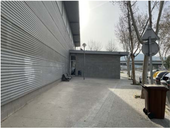
9 - Espai exterior poliesportiu
