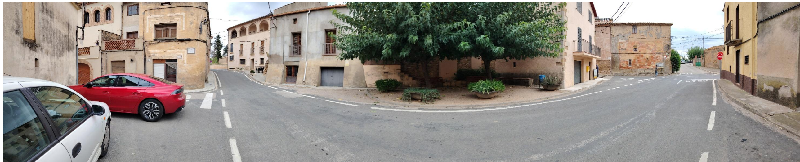
Fotografia 14: Vista panoràmica de la plaça Major
