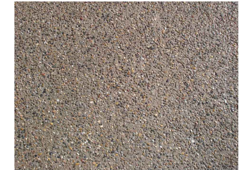
Paviment de formigó desactivat
