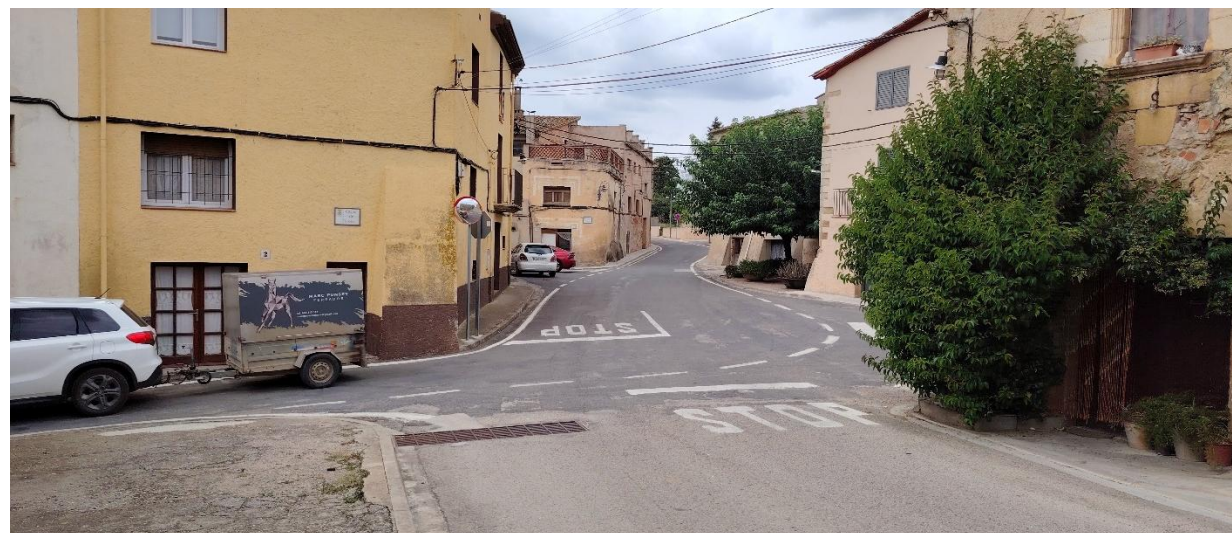
Fotografia 1: Plaça Major de Viladasens travessada per la carretera GIV-6234 i amb les xarxes elèctrica i de telecomunicacions aèries.
