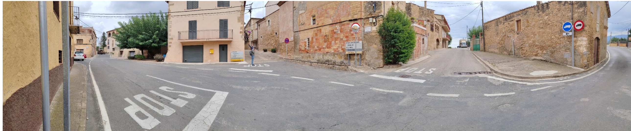
Fotografia 13: Vista panoràmica de la plaça Major
