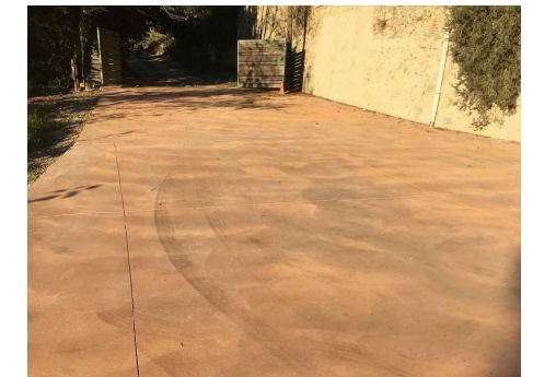
Paviment de formigó acolorit
