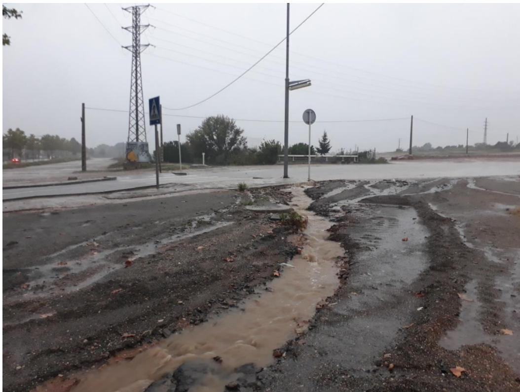
Figura 10. Entrada a rotonda de Camí del Roquí. Se puede apreciar el arrastre de sedimentos y la rodera creada por la escorrentía. Ajuntament de Reus.
