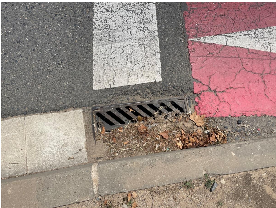
Figura 49. Detalle de imbornal EM1360091 semicolmatado.
