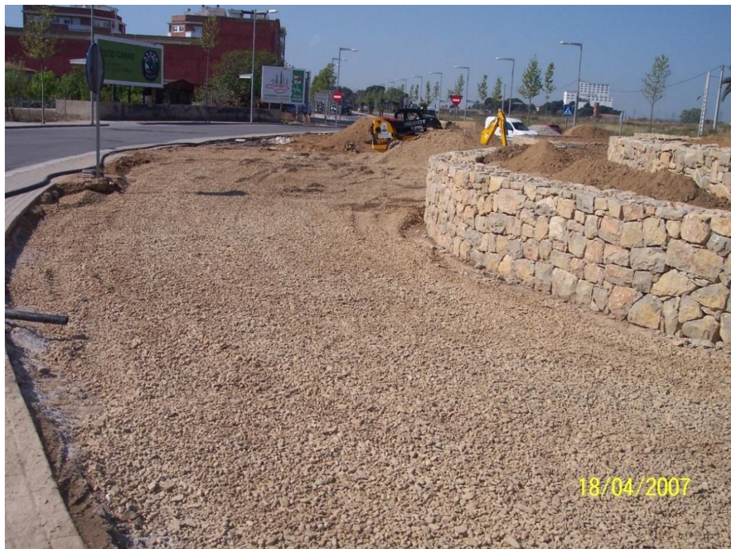
Figura 4. Aporte de material de relleno. Ajuntament de Reus.
