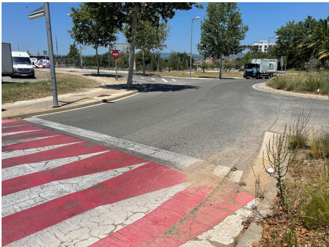
Figura 45. Salida de la rotonda por la zona Suroeste hacia la Avinguda de Riudoms donde se aprecia el pas de cebra peraltado existente y una acumulación de finos en el margen de la carretera junto a la mediana.
