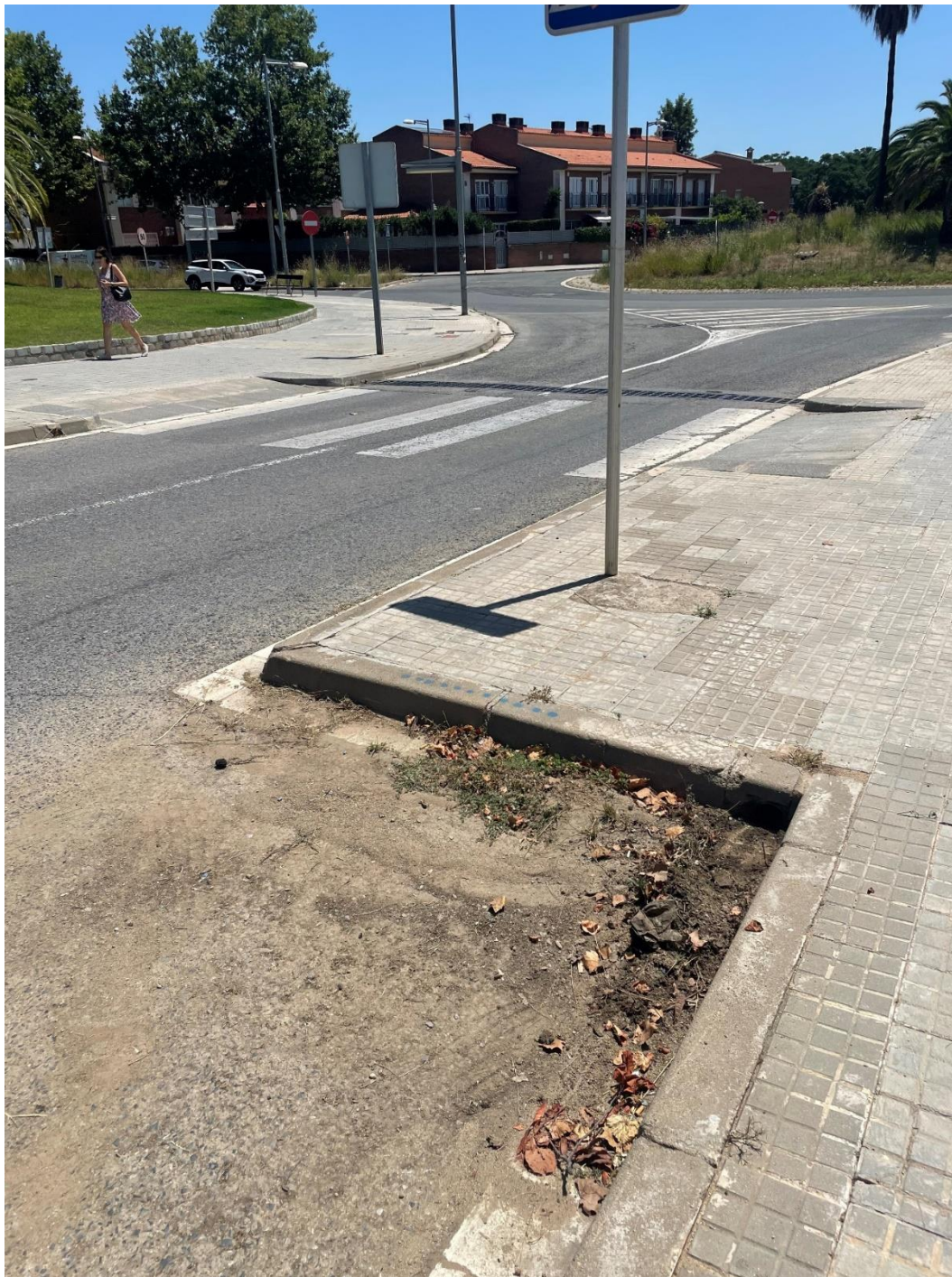
Figura 22. Detalle del arrastre de sedimentos del Carrer de la Ginesta que obstaculiza la entrada de agua a la canalización del aparcamiento.
