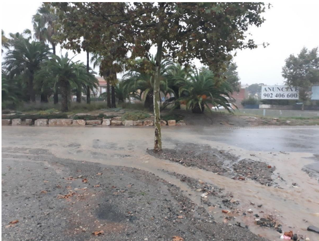
Figura 11. Prolongación de la rodera que encauza la escorrentía y detalle de los sedimentos arrastrados. Ajuntament de Reus.
