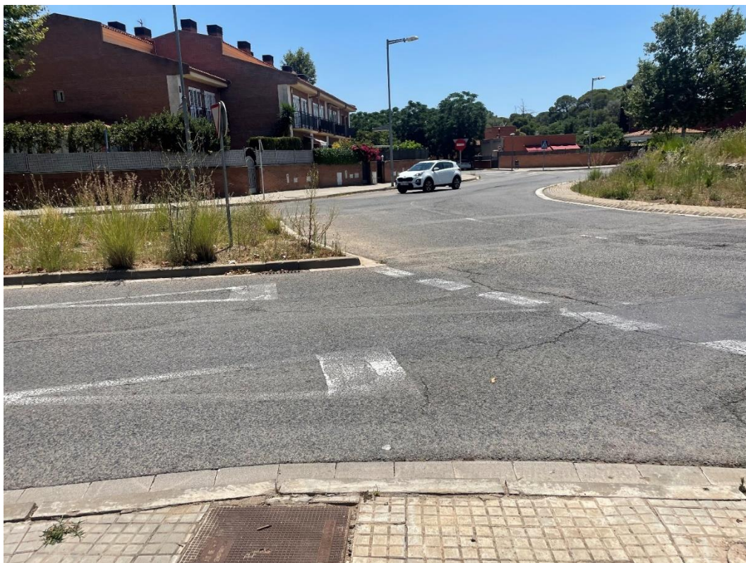
Figura 28. Detalle de la entrada a la rotonda por la zona noreste de la Avinguda de Riudoms donde se aprecia sedimentación de finos.
