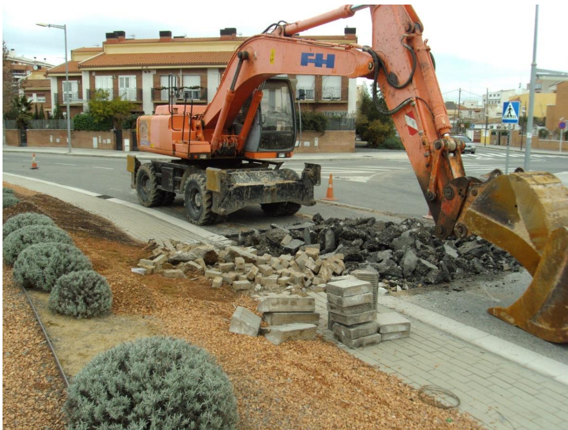
Figura 25. Demolición de carretera y rigola para su reparación. Fuente: Ajuntament de Reus.
