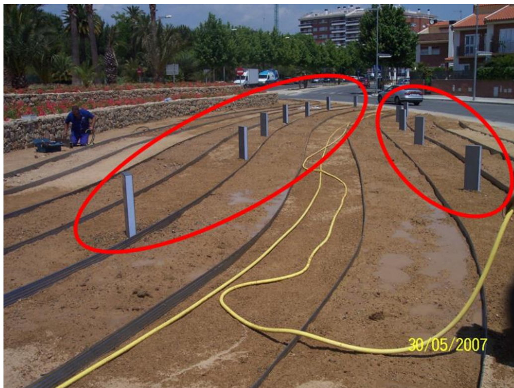
Figura 11. Instalación del alumbrado ornamental del interior de la rotonda. Fuente: Ajuntament de Reus.
