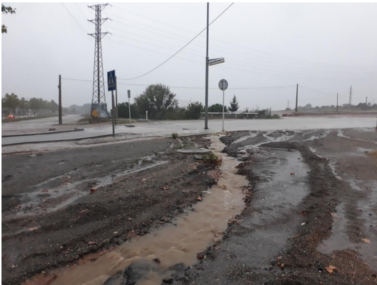
Figura 1. Entrada a rotonda de Camí del Roquís. Se puede apreciar el arrastre de sedimentos hacia la rotonda y la rodera creada por la escorrentía.
