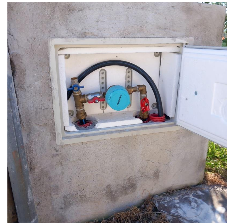
Figura 3. Comptadors d'aigua de la xarxa municipal de Santa Coloma de Queralt. (3)
