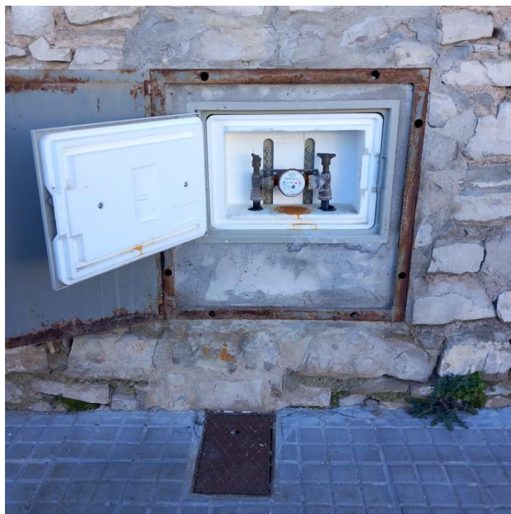
Figura 9. Comptadors d'aigua de la xarxa municipal de Santa Coloma de Queralt. (9)
