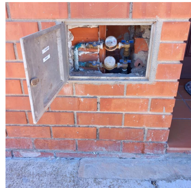
Figura 7. Comptadors d'aigua de la xarxa municipal de Santa Coloma de Queralt. (7)
