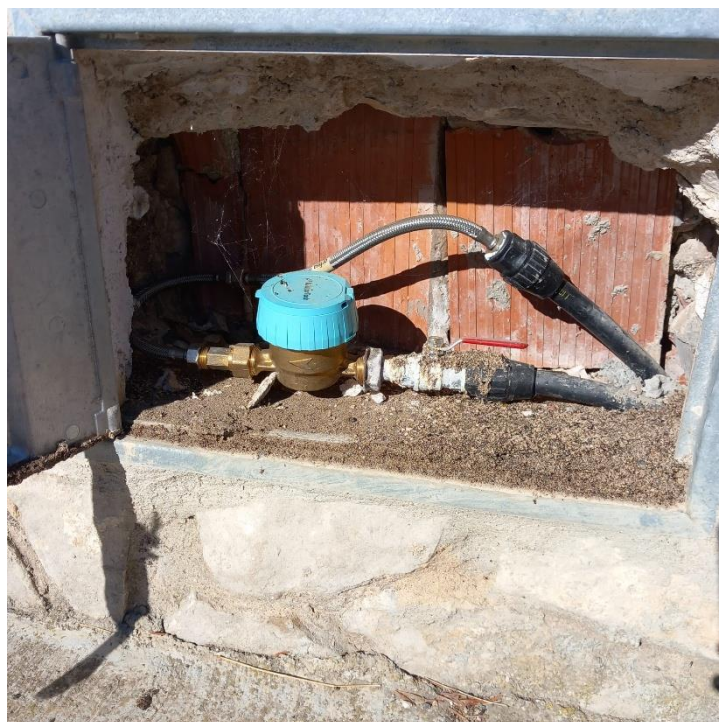
Figura 5. Comptadors d'aigua de la xarxa municipal de Santa Coloma de Queralt. (5)
