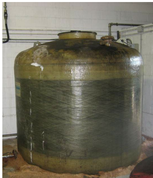
Figura 2. Dipòsit sense doble cubet
