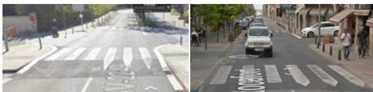
Plataforma reductora de velocitat en cruïlla
