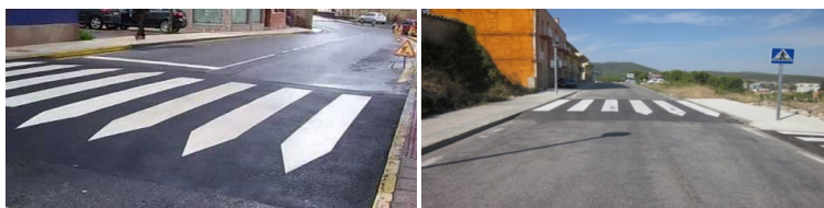
Pas de vianants elevat
