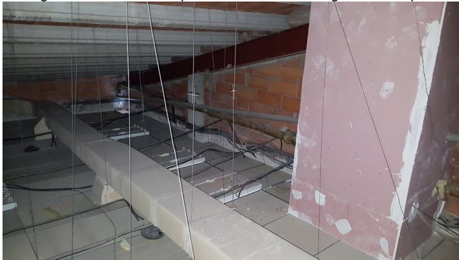
Imatge de l'estructura en la part baixa de la coberta
