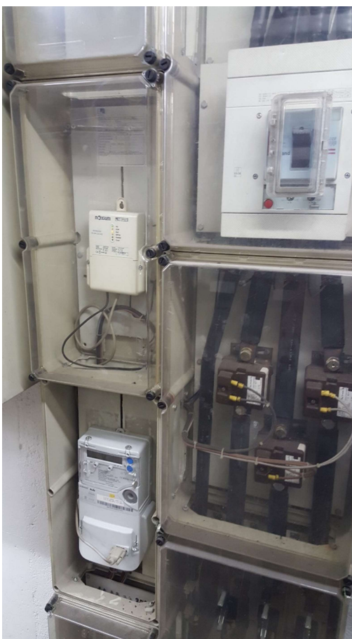
Imatge de la TMF de la climatització
