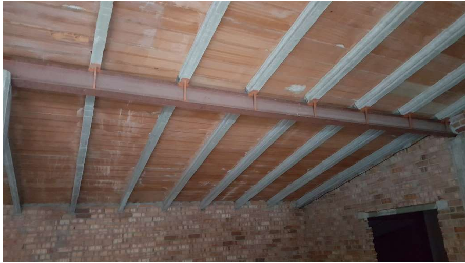
Imatge de l'estructura en la part alta de la coberta. Biga amb tornapunts
