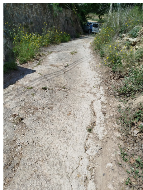
Fotografia 5 Tram 2. Traçat proper a la riera
