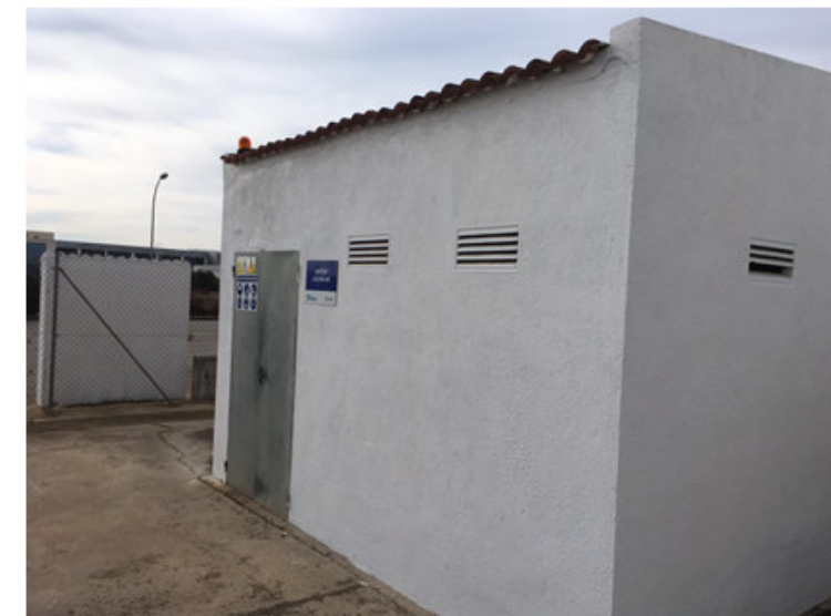
Fotografia 3 Vista exterior de la caseta de bombament de l'Albornar
