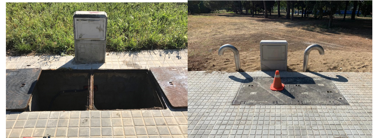
Figura 15 Exemples d'execució d'arquetes amb armari de comunicacions
