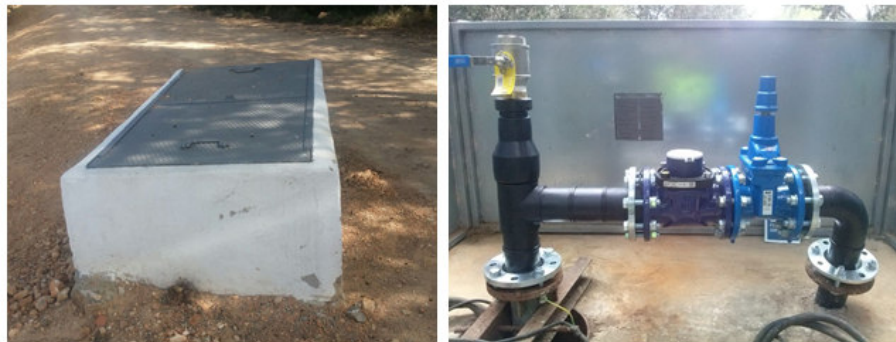
Fotografia 2 Esquerra: Arqueta pou 2 Idiada. Dreta: Brocal pou 3 Idiada
