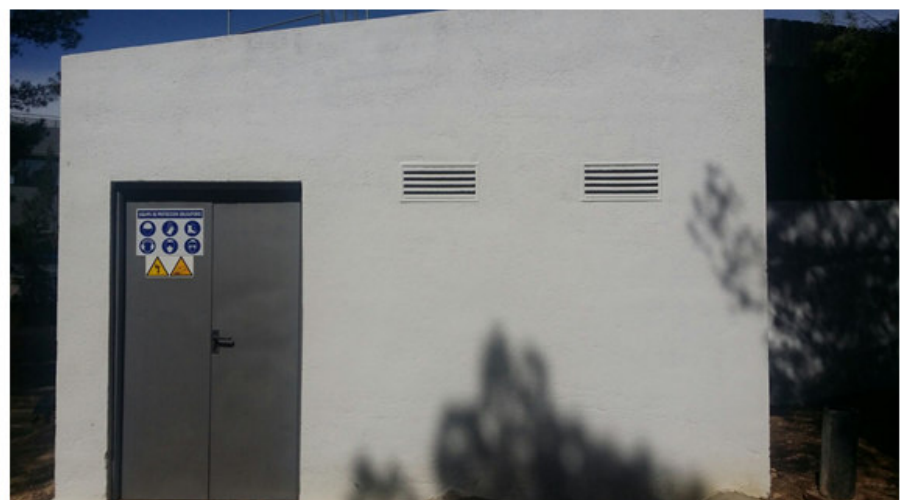
Fotografia 5 Caseta annexa del dipòsit d'Idiada
