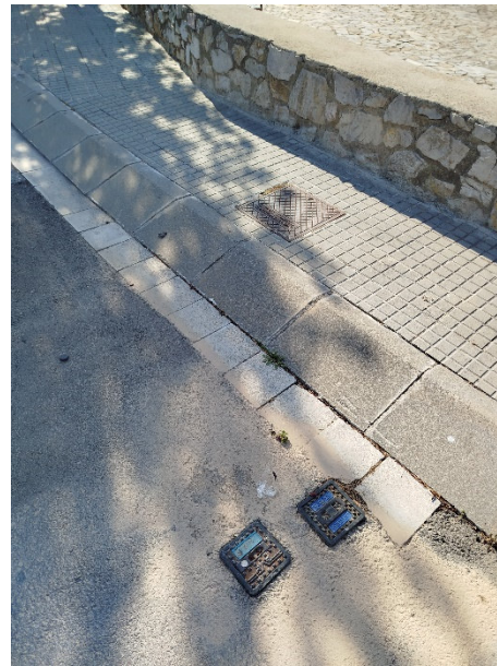
Fotografia 28 Detall trampillons en la ubicació de l'arqueta del Camí de l'Arboç
