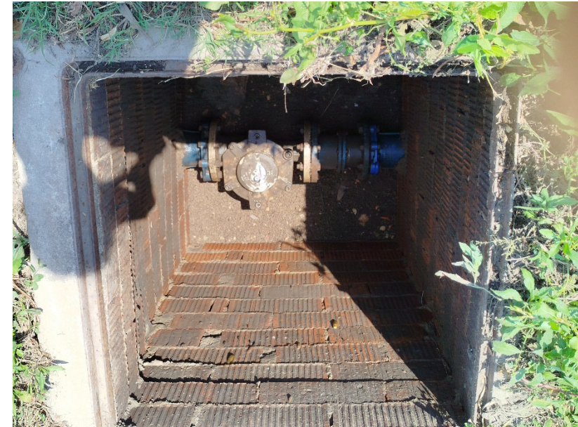
Fotografia 26 Detall arqueta existent en la ubicació arqueta sectorització Molí d'en Serra i Torrent del Lluch
