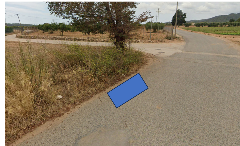
Fotografia 23 Ubicació arqueta sectorització ompliment dipòsit nucli
