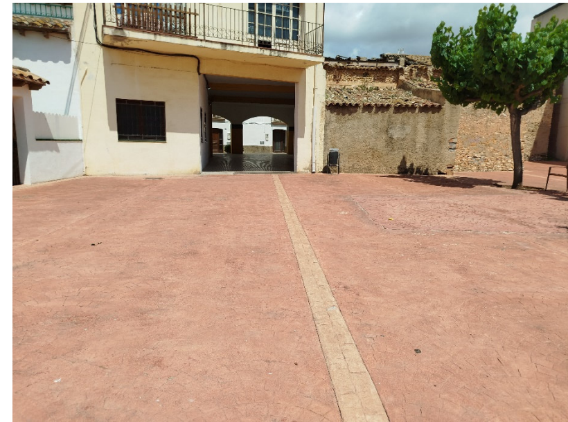
Fotografia 6 Tram 3. Detall del formigó imprès
