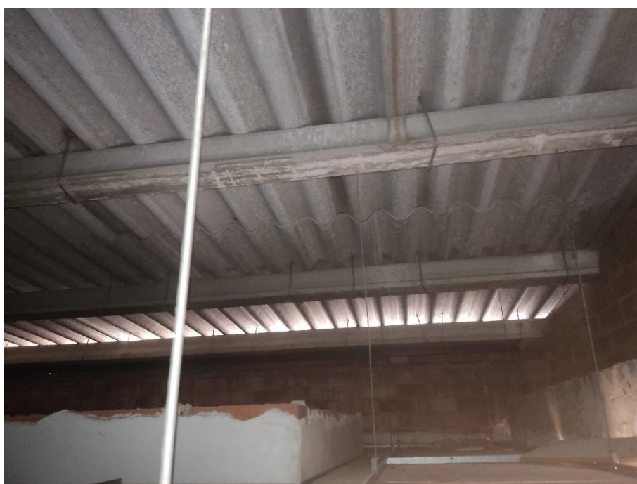
F07. Vista coberta existent fibrociment i corretges de formigó
