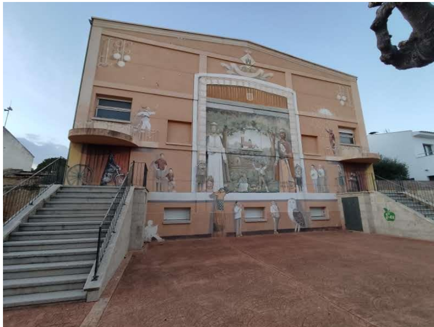
F01. Façana carrer Montserrat Roig
