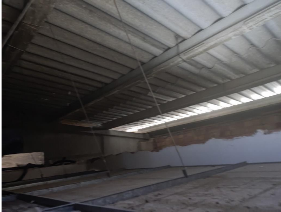
F08. Vista coberta existent fibrociment, corretges de formigó i bigues Delta
