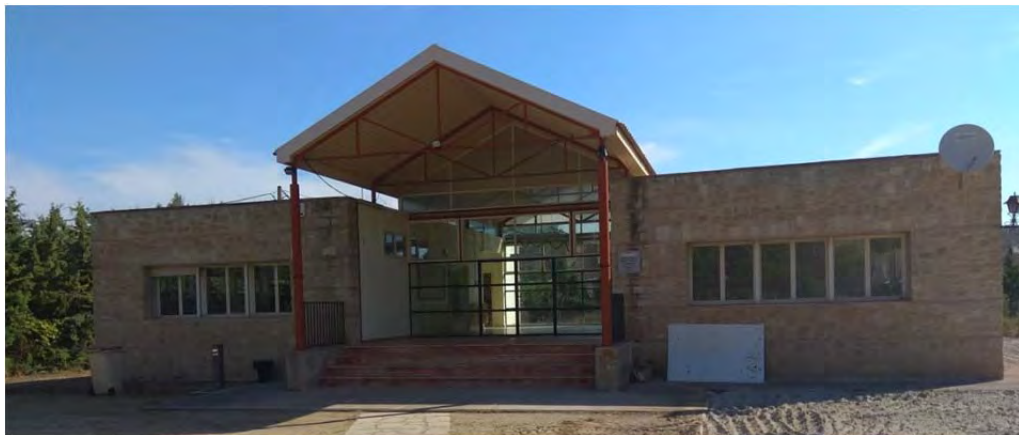
Vista de la façana principal (sud) de l'edifici socio-cultural
