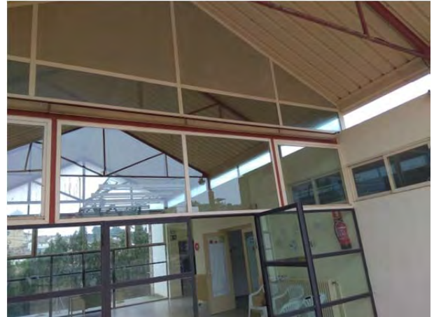
Vistes fusteria exterior a substituir per altra energèticament eficient
