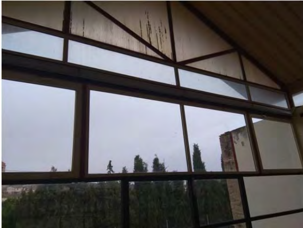
Vistes fusteria exterior a substituir per altra energèticament eficient
