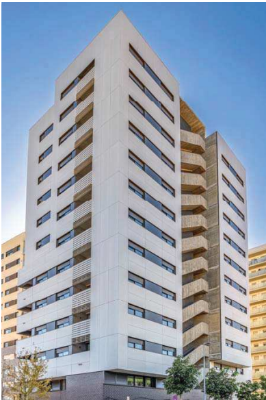
Façana al Passatge dels Rosers
