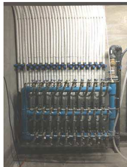
Bateria de comptadors individuals situats a armari de planta baixa
