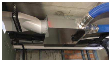
Extractor situat al sostre del bany
