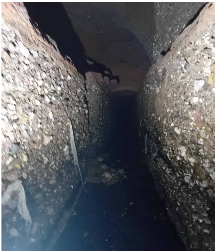
Esvoranc sota aparcament: Vista de col·lector col·lapsat, parets descalçades, i el sostre totalment desaparegut, generant una gran cavitat.
