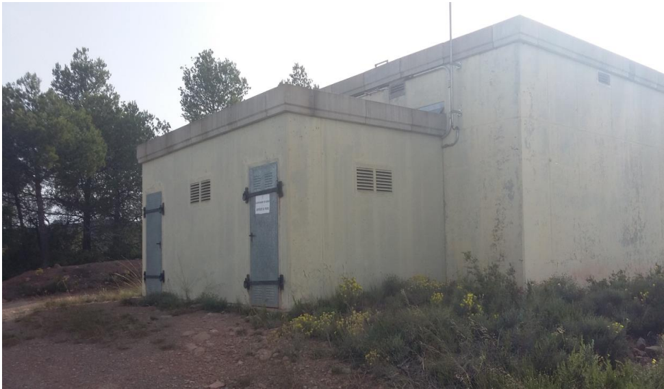
Imatge1. Inici del projecte amb el Dipòsit del Puig en primer terme.
