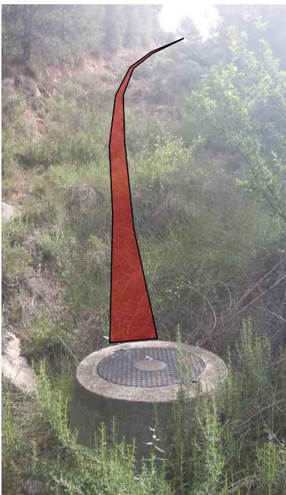
Imatge 10 i 11. Vistes de la pista que abandona el punt fondo i puja en direcció a Querosa-Cererols. En primer pla, al PK1+360, l'arqueta de desguàs de les canonades alta i baixa, a on s'observa també el tub de polietilè com surt a la llera del torrent.
