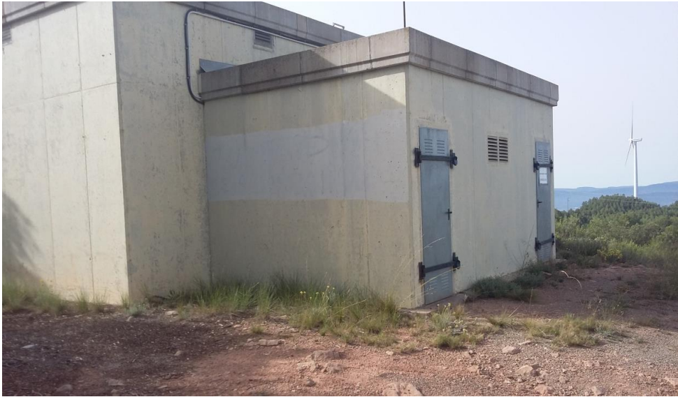
Imatge2. Altre perspectiva PK0+000 del dipòsit del puig a l'exterior del qual iniciarem la connexió.
