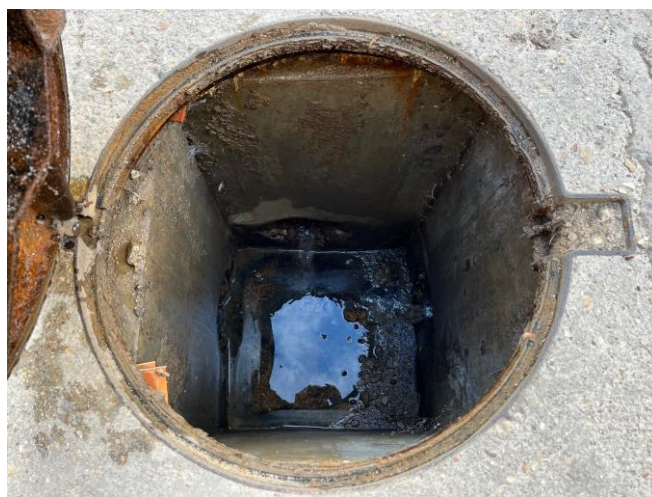
Foto Núm. 10 Vista de l'interior d'un dels pous de registre de la xarxa de sanejament on s'aprecien els tubs existents de formigó
