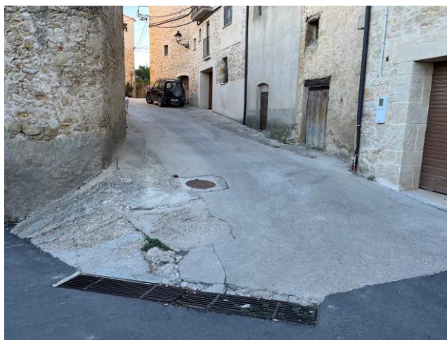
Foto Núm. 8 Reixa en el c/ Onze de Setembre on es desaguaran les aigües de pluja interceptades en la reixa del c/ Lluís Companys
