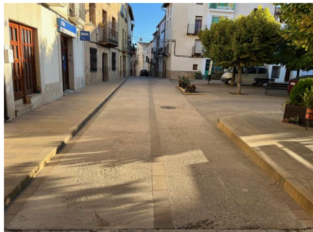
Foto Núm. 2 Vista del c/ Lluís Companys després del porxo i pou de registre afrontat a la plaça Catalunya on s'inicia la xarxa de clavegueram a renovar
