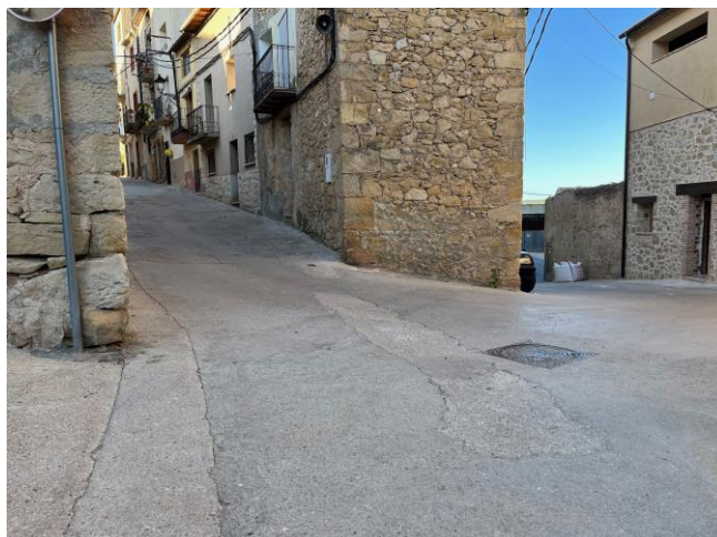
Foto Núm. 6 Intersecció del c/ Lluís Companys amb el c/ Nou i darrer pou de registre de la xarxa de clavegueram a renovar
