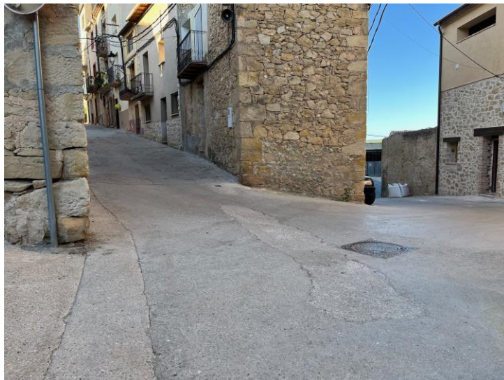
Foto. núm. 4: Vista de la intersecció del c/ Lluís Companys amb el c/ Nou on s'executarà una reixa de pluvials per la recollida de les aigües pluvials canalitzades per la rigola central
