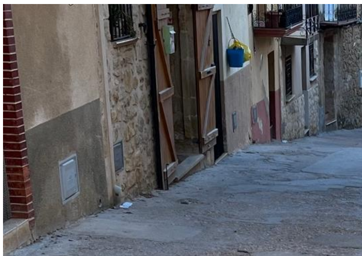
Fot. núm. 3: Vista dels armaris existents a les façanes de la xarxa d'aigua
