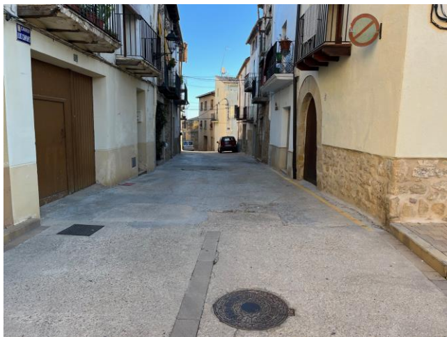
Foto Núm. 3 Continuació del c/ Lluís Companys passada la plaça Catalunya i 2 on pou de registre de la xarxa de clavegueram a renovar
