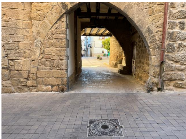
Foto Núm. 1 Pou de registre en el c/ dels Dolors on desaigüen els habitatges del porxo que esta a l'inici del c/ Lluís Companys
