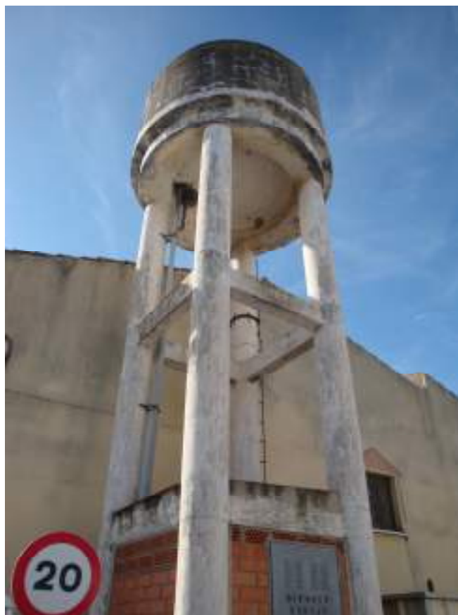
Fotografia 63: Dipòsit elevat d'aigua potable
