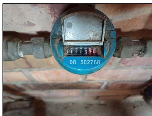
Figura 7. Exemple de comptador analògic.
