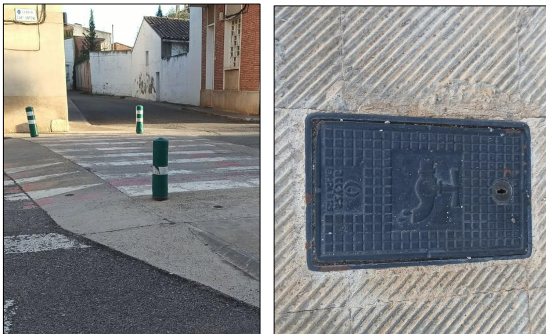
Figura 31. Punt de connexió amb Carrer Lleida i Balmes i comptador existent a l'exterior (F11).
