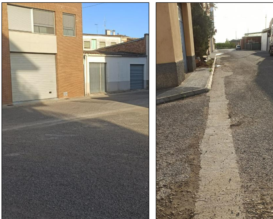
Figura 26. Punt de connexió final de l'actuació en el tram del Carrer Enric Granados amb l'obra del Carrer Barcelona (F8).
