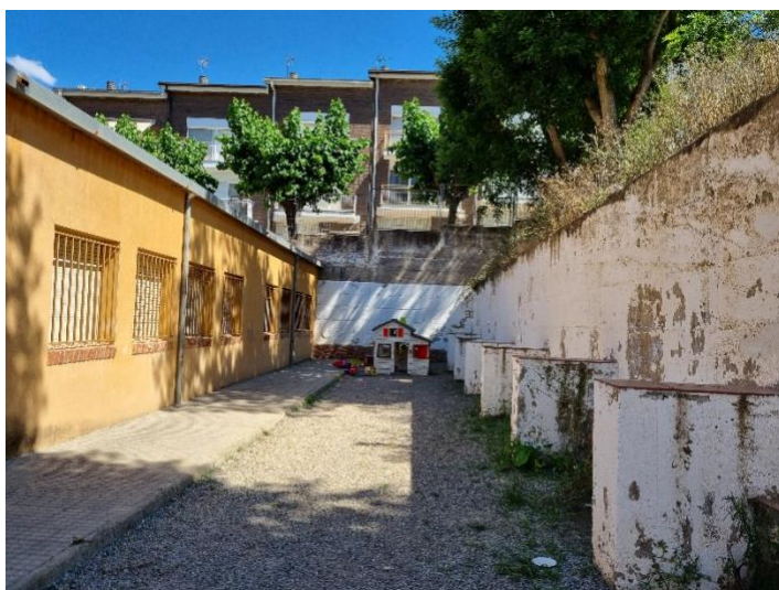
Vistes de l'exterior del pati posterior
