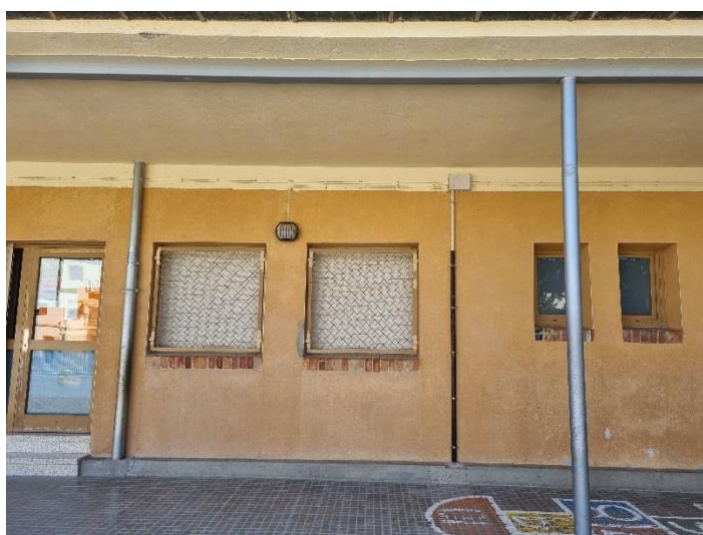
Vistes des de l'exterior façana principal Nord-Est
