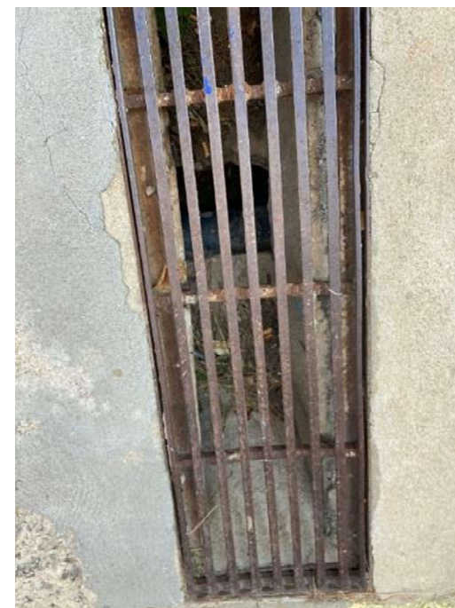
Figura 21. Reixes de captació d'aigua superficial existents
