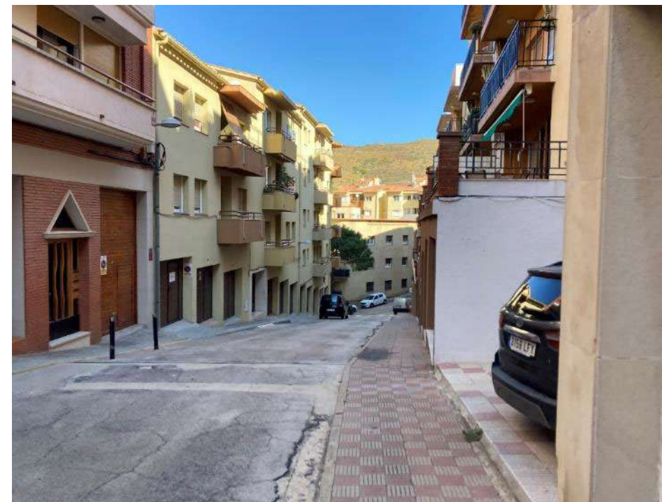
Figura 18. Estat actual vorera i paviment de calçada del carrer del Pi.
