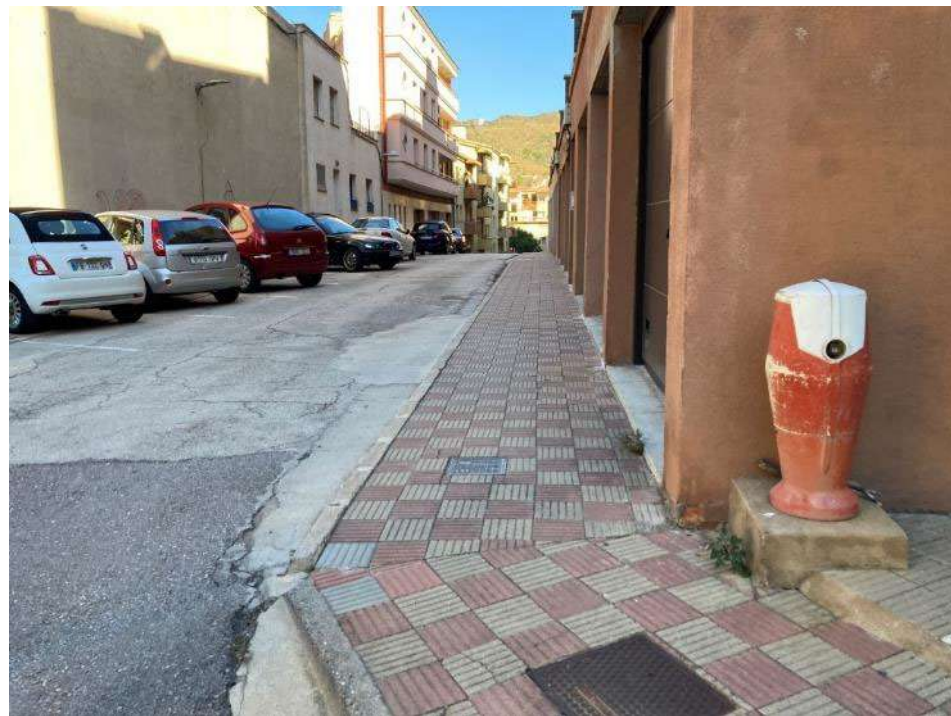
Figura 15. Estat actual. Serveis i pavimentació existent. A l'esquerra, zona d'aparcament en semi-bateria.
