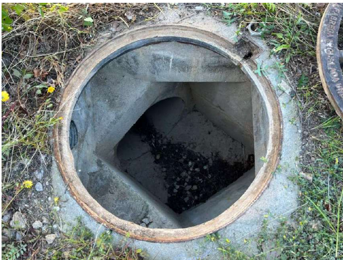
Vista del pou existent de sanejant a l'interior de terreny.
