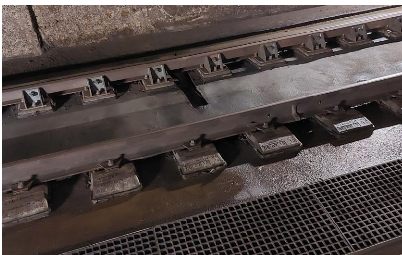
Imatge 12. Exemple drenatge transversal a obrir
