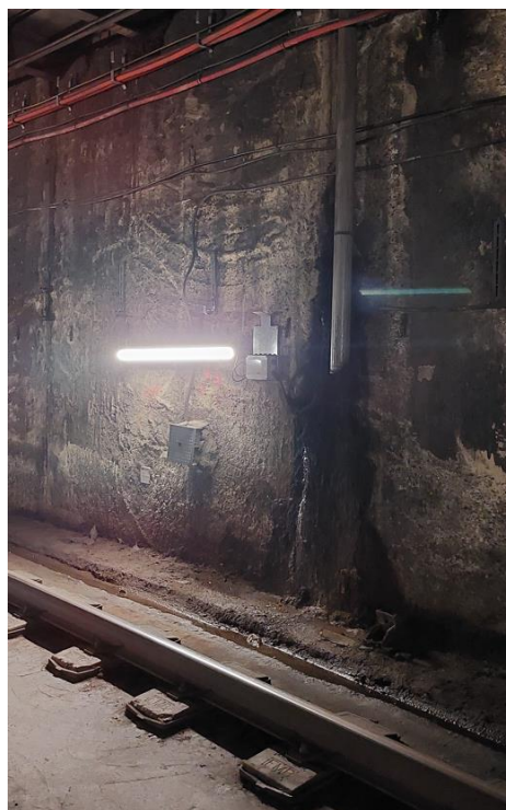
Imatge 14. Tub sense completar PK110+912
