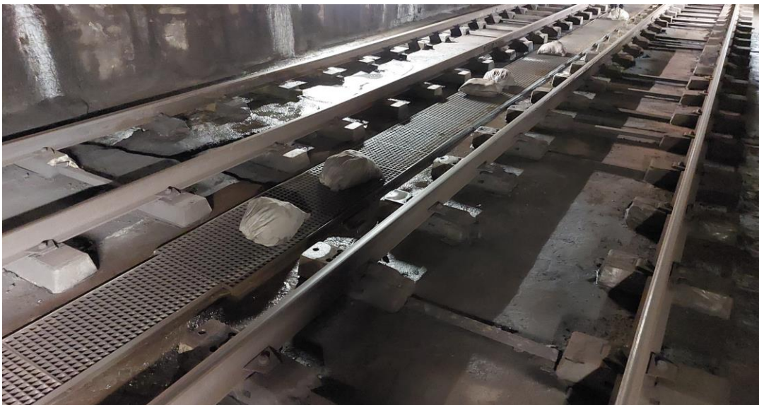
Imatge 6. Fotografia estat via tram PK 110+565 a 110+520.
